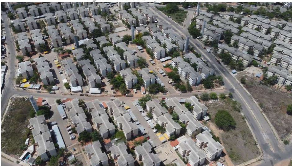
Figura 50 - Vista aérea do conjunto Cidade Jardim 1.
