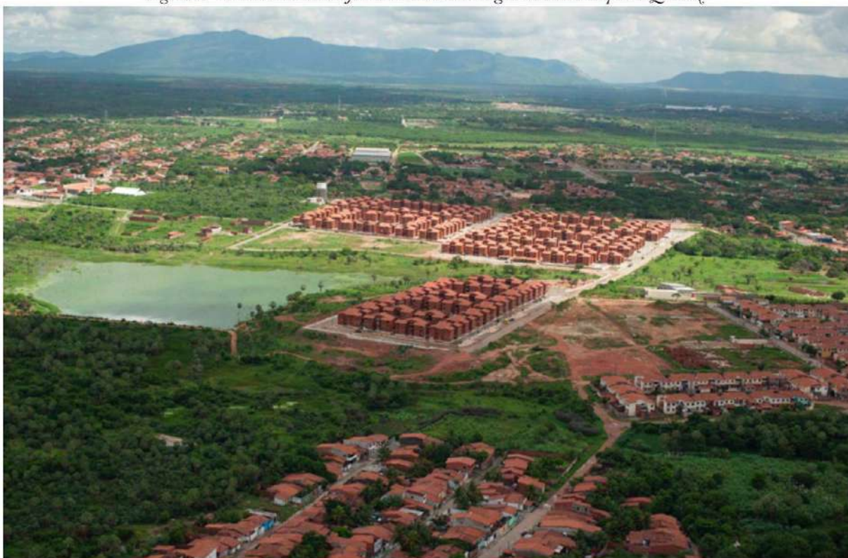
Figura 37 - Vista aérea dos conjuntos habitacionais Miguel Arraes e Raquel de Queiroz.
