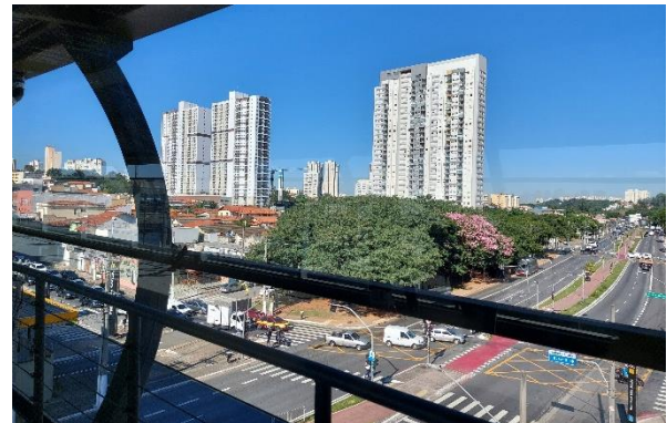
Lançamentos imobiliários – Estação Vila Sônia, Linha 4-Amarela
