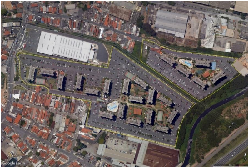
Figura 55. Grandes áreas impermeabilizadas de estacionamento no interior dos empreendimentos
