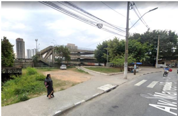
Escadas e rampas para acesso à Estação Presidente Altino.
