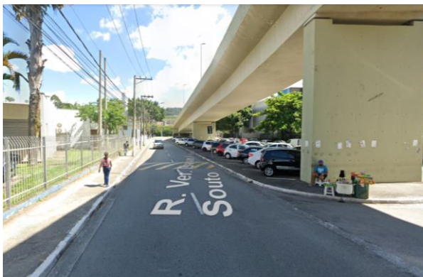
Baixio de viaduto para acesso à Estação Belval.
