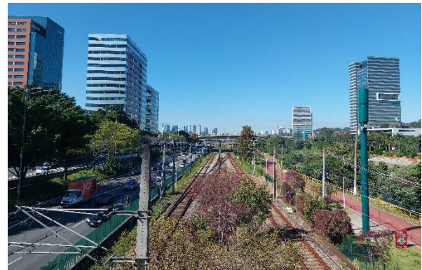
Edifícios de escritório – Estação Pinheiros, Linha 9-Esmeralda/Linha 4-Amarela
