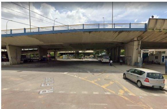
Baixio de viaduto para acesso à Estação Prefeito Saladino. Fontes: A autora, 2022, Google Earth e Google Maps.
