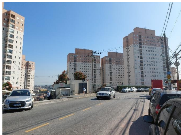
Flex Carapicuíba , 1.340uhs, 13 edifícios, em Carapicuíba.
