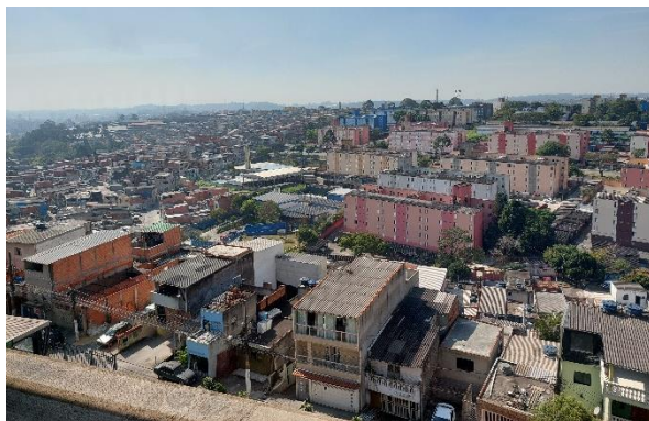
Conjunto habitacional, favela e loteamento irregular – Estação Jardim Planalto, Linha 15-Prata
