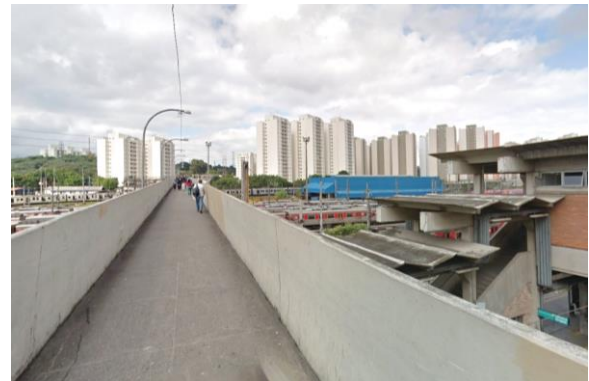
180 metros de passarela para acesso à Estação Presidente Altino.
