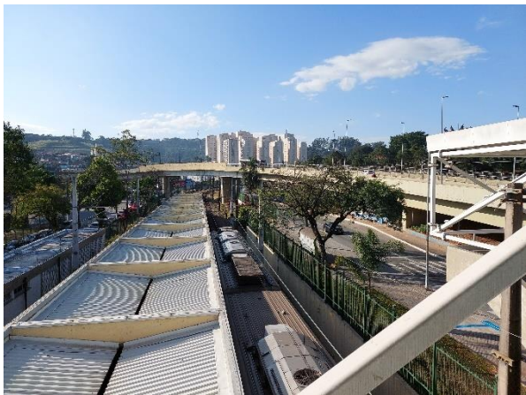
Estação Belval (Linha 8), em Barueri, e empreendimento Inspire Barueri ao fundo.
