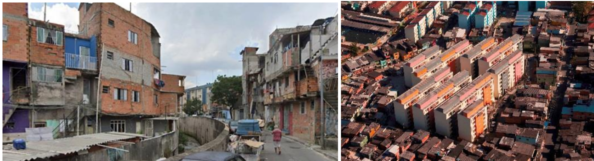
Figuras 49 e 50 — Gleba A: à esquerda, readensamento às margens do Córrego Sacomã; À direita, Conjuntos CDHU entregues em 2009. Fonte: Google Maps (2021) e SEHAB/SP (2017).
