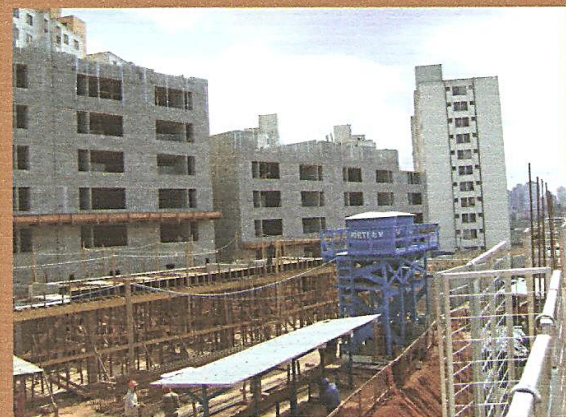
CERATTI - EM ANDAMENTO
