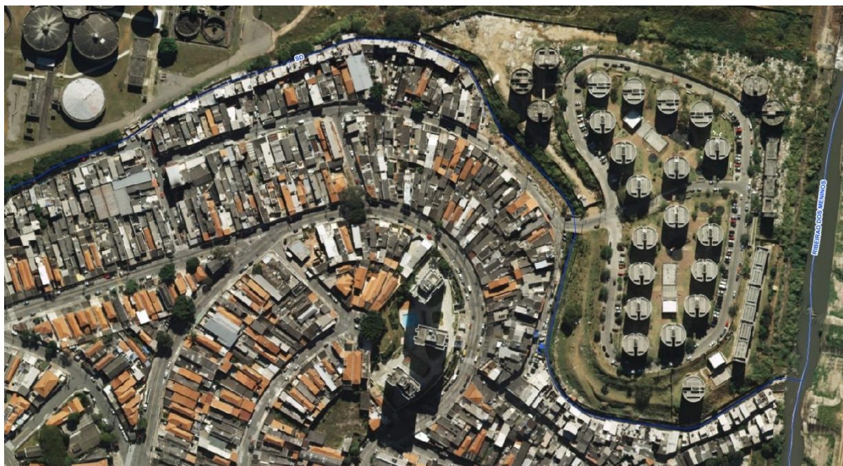
Figura 82 – Foto aérea de 2020 demonstrando reocupação do Córrego Independência em Heliópolis, canalizado no início dos anos de 2010 por obra vinculada ao PAC, mas, onde reincide risco hidrológico por consequência das novas ocupações. Fonte: Geosampa, MAPA DIGITAL DA CIDADE, 2023.
