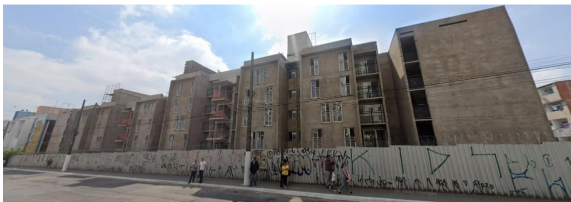
Figura 70 — Empreendimento em construção ao Lote B da Gleba G, destinado a 221 habitações, as quais foram iniciadas em 2014 e tiveram suas obras paralisadas pela necessidade de projetos complementares de cortina de contenção, não previstos originalmente. As obras foram retomadas em agosto de 2017 e encontram-se previstas de conclusão em 2023. De acordo com a SEHAB, 2017, a obra estava orçada em R$ 33 mi no Plano Plurianual (PPA), a serem executados com recursos PMSP/FMSAI. Fonte: Google Maps (2022).
