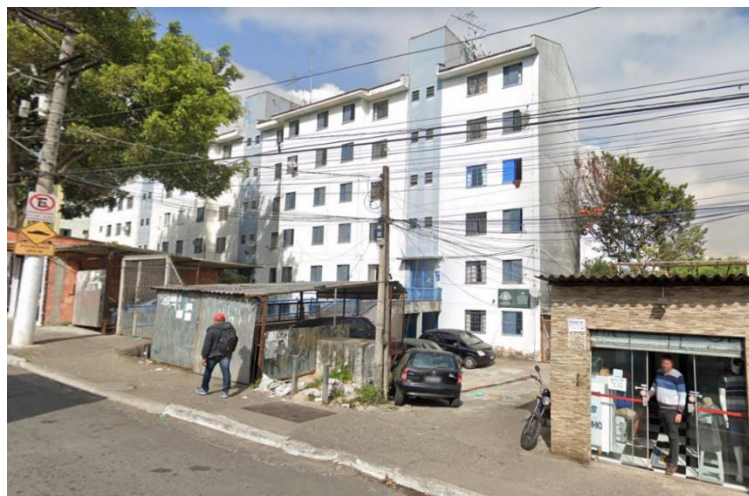
Figura 39 — Edifício do Programa Cingapura à Gleba A, concluído em 2004, visto da Avenida Almirante Delamare, com térreo e quatro pavimentos superiores, além de inferiores, acessíveis por rampa intermediária, para se dispensar o uso de elevadores, conforme as prescrições iniciadas pelo Decreto n. 14.025/1976. Na imagem, são também percebidas as execuções irregulares de garagens cobertas e comércios, não previstos pelo Programa. Fonte da imagem: Google Maps, acesso em 11/08/2022.
