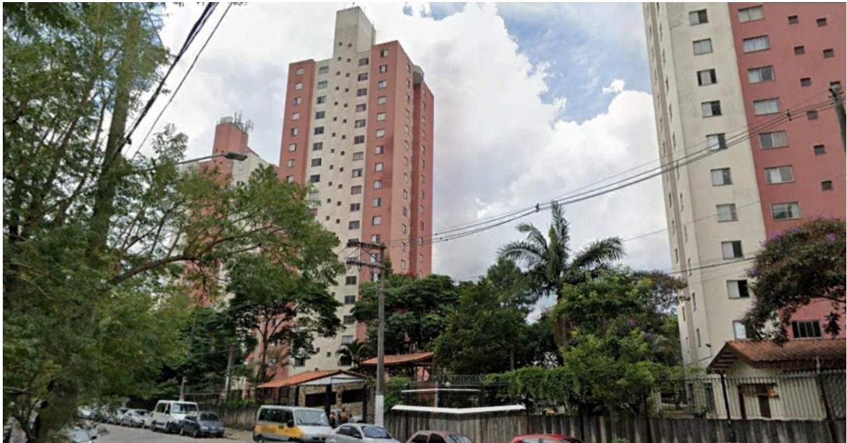
Figura 27 — Condomínio Piazza San Carlo, à Rua Barão do Rio da Prata. Fonte: Google (2022).
