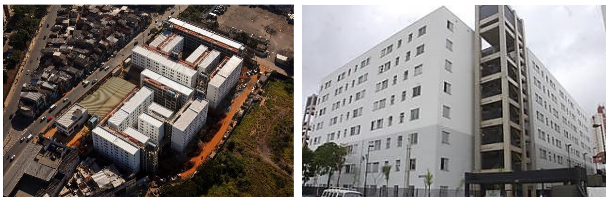
Figura 57 — Conjunto Comandante Taylor, entregue em 2015 com 421 unidades, cuja pendência de regularização constava no cumprimento de Termo de Compromisso Ambiental (TCA) pelo Município.
