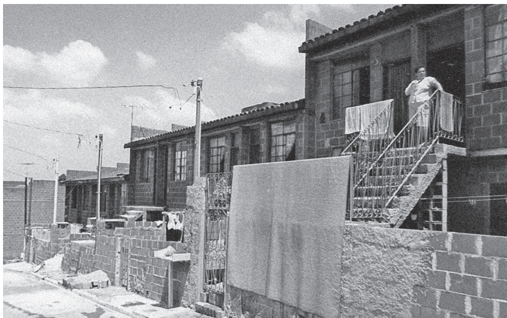
Figura 23 (acima): Canteiro de obras Mutirão Cazuza.
