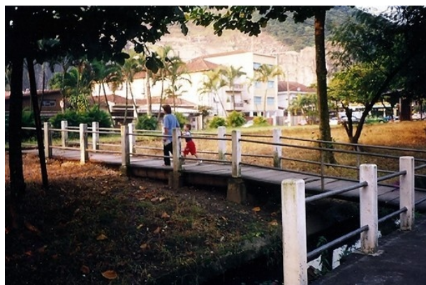
Figura 36 - Travessia da linha férrea da Fepasa (EFS) e canalização, em São Vicente/ SP (1997)
