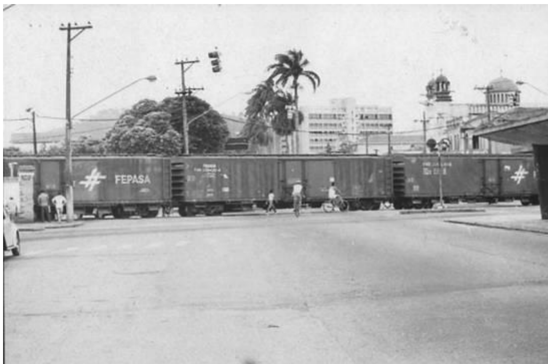
Figura 81 - Manobra de composições na Avenida Ana Costa, junto da estação de mesmo nome, na década 1980
