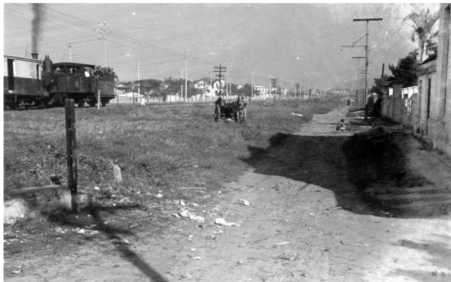
Figura 75 - Vista 1: Avenida Francisco Glicério 66
