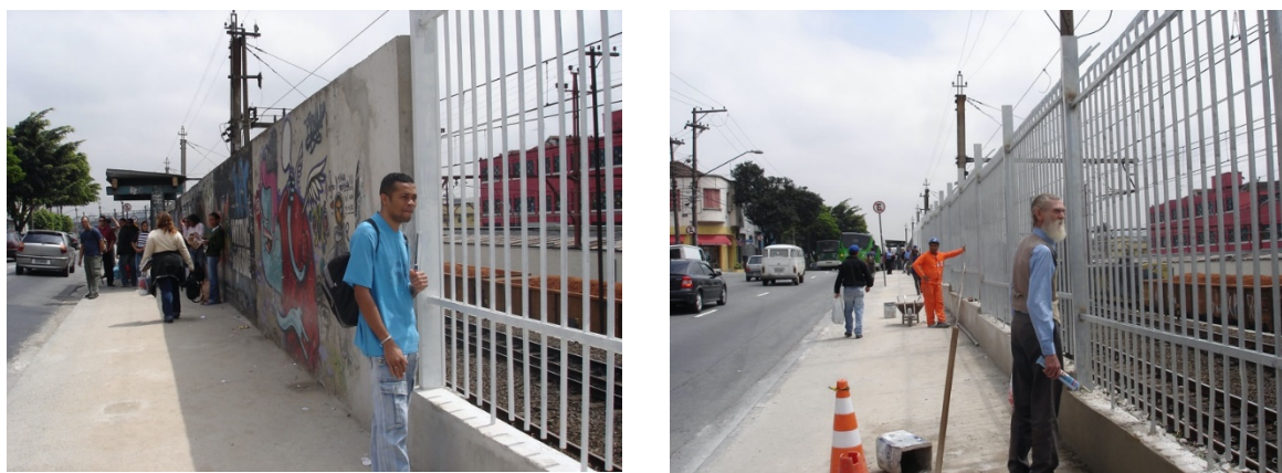
Figura 33 - Substituição dos muros, menos permeáveis e reafirmadores da condição de rompimento ferroviários, por gradis, promovendo uma vedação que permite maior permeabilidade visual.
