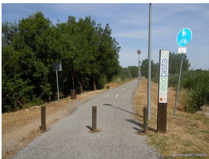
Figura 40 - Ecopista de Évora - Ramal de Mora
