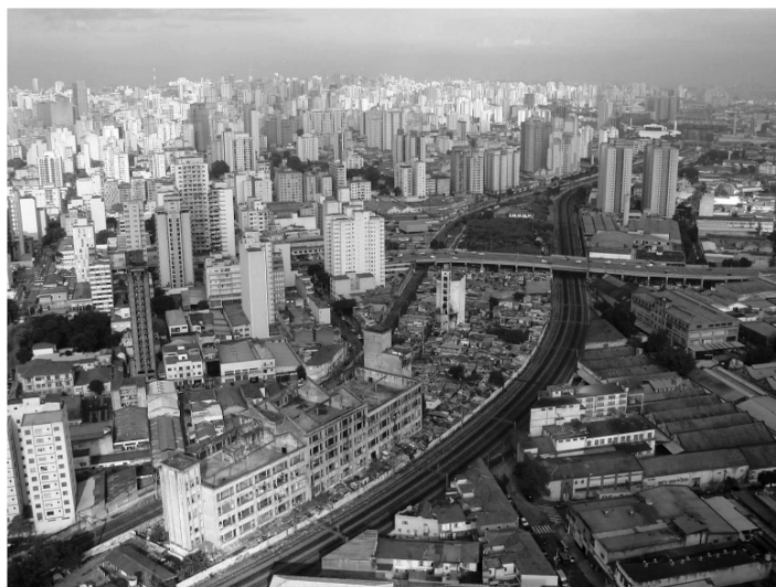
Figura 31 - Infiltração – surgimento das superfícies de contato. Favela do Moinho, São Paulo 46
