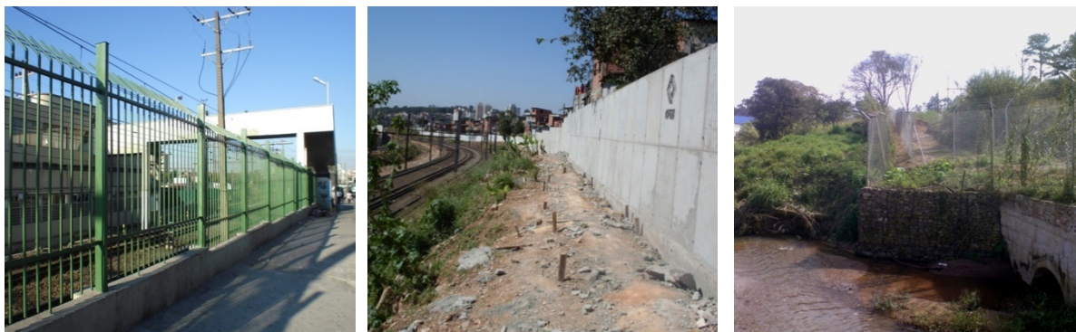
Figura 32 - Três situações características de vedações existentes na malha da CPTM 49
