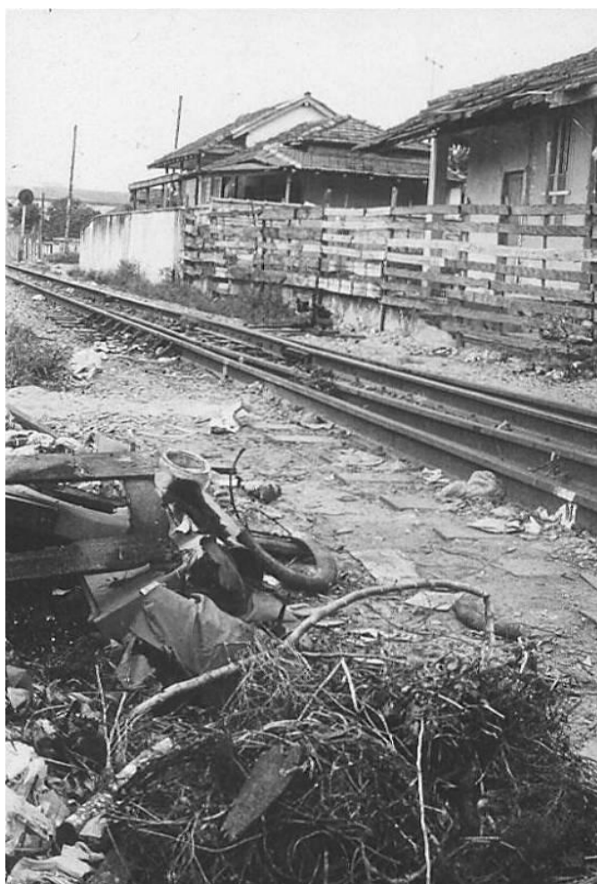
Figura 89 - Desvio ferroviário, no bairro do Macuco/Estuário
