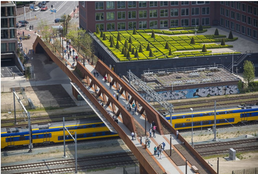
Fonte: Benthem Crouwel Architect Paleisbrug. Fotografia: Jannes Linders.
