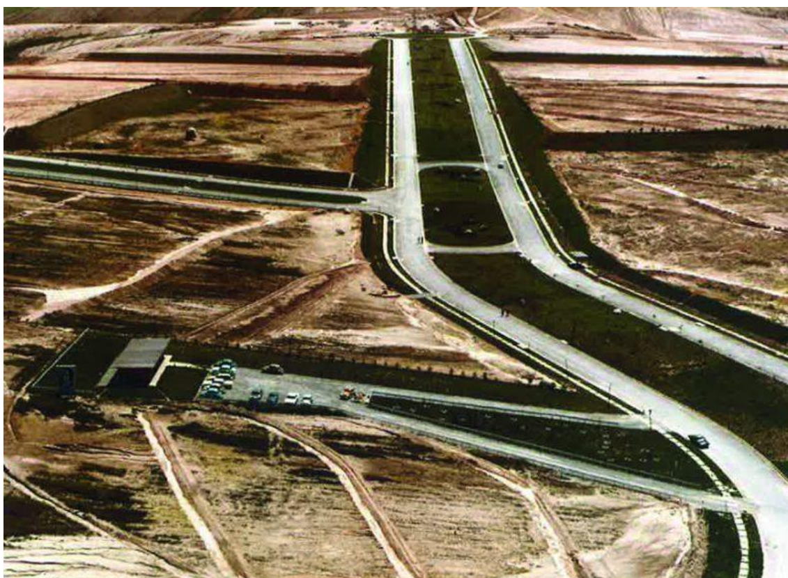
Figura 35 – Foto área com o início das obras de implantação de Alphaville. Fonte: www.vero.com.br
