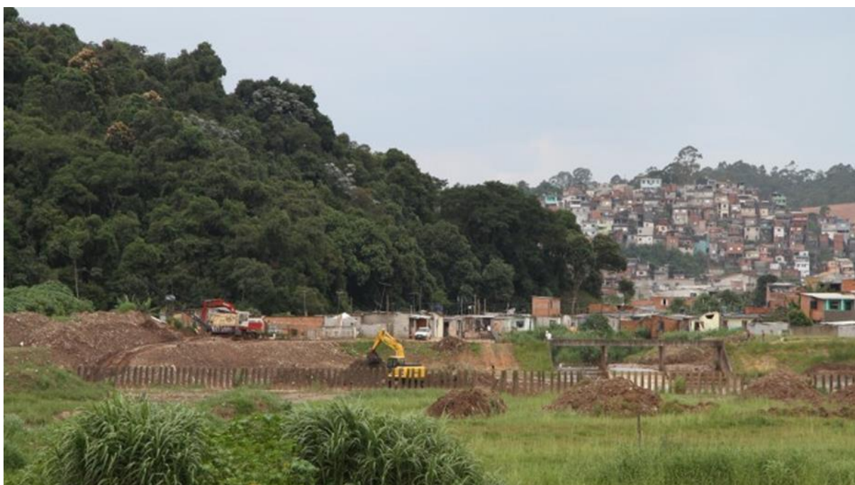
Figura 2.2: Limpeza do piscinão Aricanduva II, em São Mateus, com retroescavadeiras. Adaptado pelo autor. Fonte: Portal R7, 2010.
