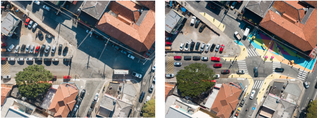
Imagem 60 | Antes e depois das intervenções de melhorias na geometria do viário e ampliação dos espaços para pedestres. O manual não cita a localização dessas imagens. Fonte: Manual de Desenho Urbano e Obras Viárias, 2021.
