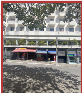
EDIFÍCIO TOMBADO, USO MISTO
