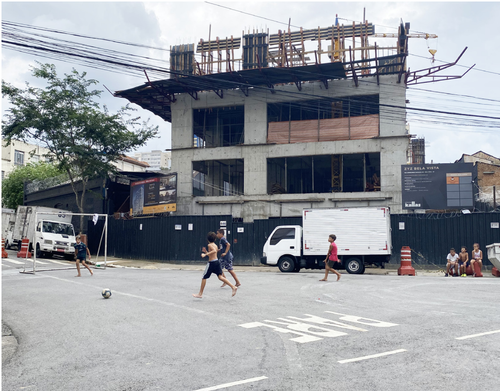
Imagem 34 | Larguinho da Maria José e o empreendimento ZYZ Bela Vista sendo construído. Fonte: Foto da autora, 2022
