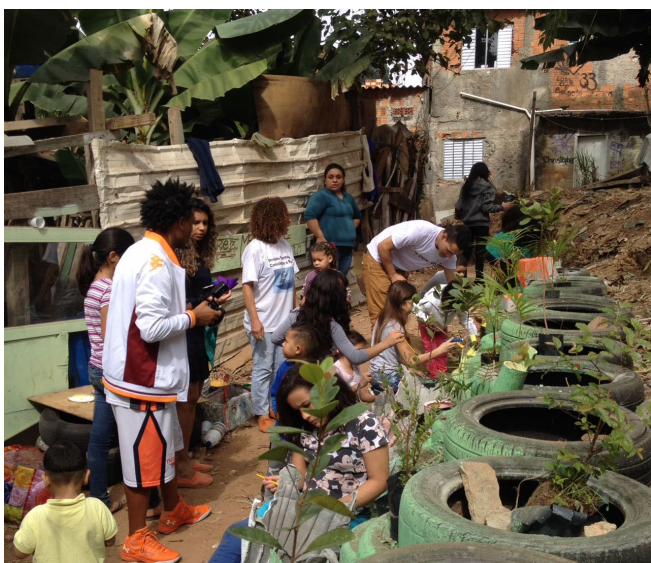
Figura 133 - Primeira fileira da contenção de pneus. Fonte: Material de divulgação Fazendinhando, 2017.
