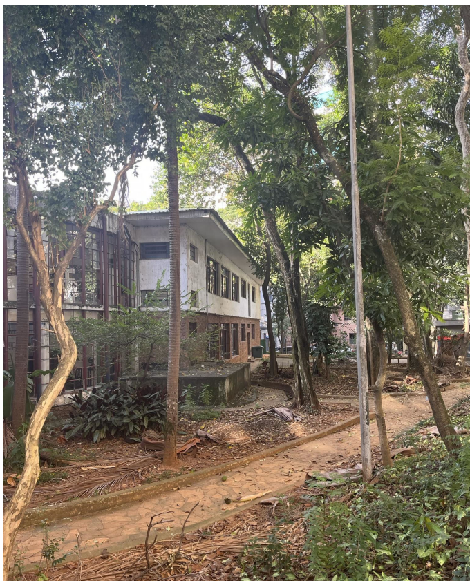
Figura 70 - Biblioteca e estacionamento restrito ao fundo.
