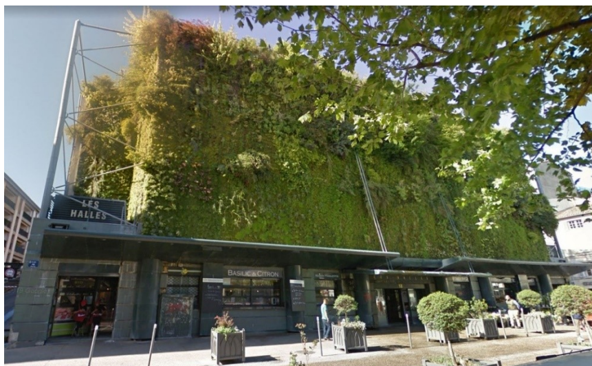
Figura 23 – Fachada verde do Mercado Municipal de Avignon, França. Fonte: Google Street View, 2019.
