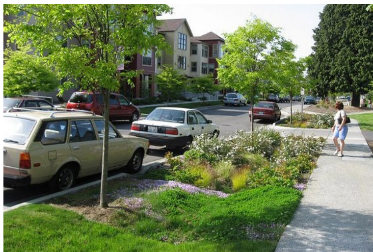
Figura 16 - Biovaletas em rua de Seattle. Fonte: EPA Office of Water, s.d.
