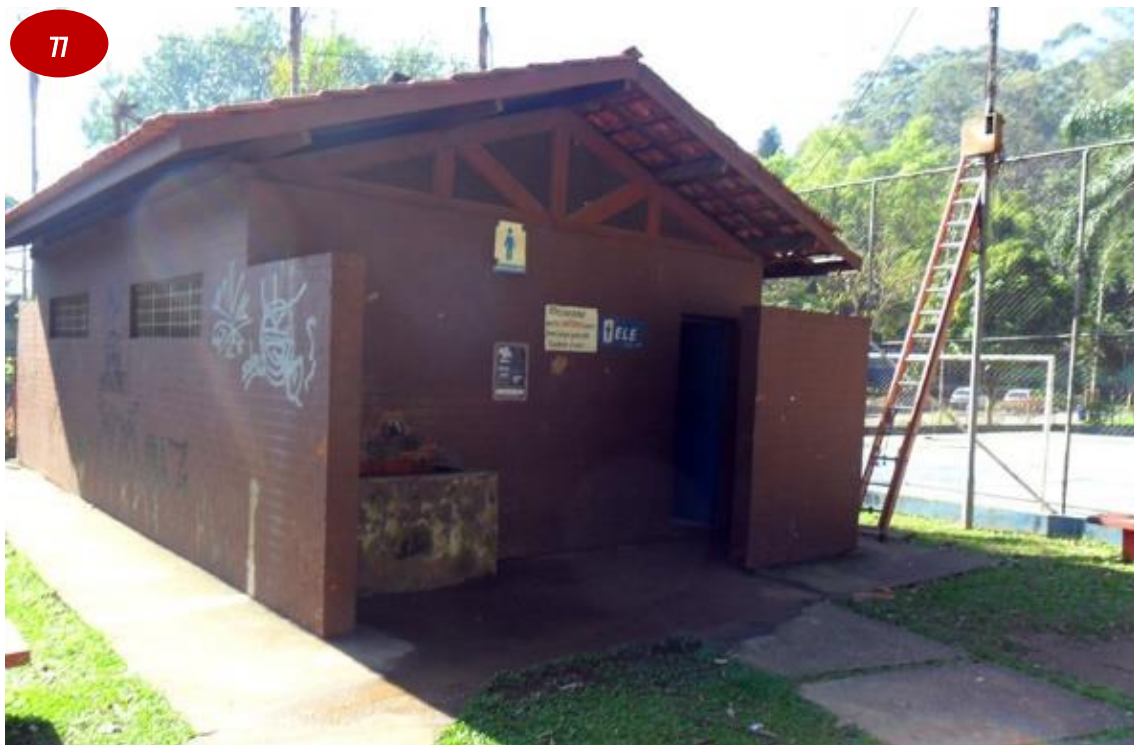
Parque do Paço: antigo sanitário, demolido durante as obras de intervenção.
