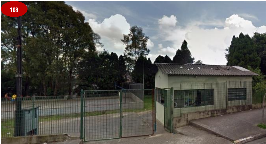
Acesso ao parque e edificação de apoio antes da intervenção de 2015
