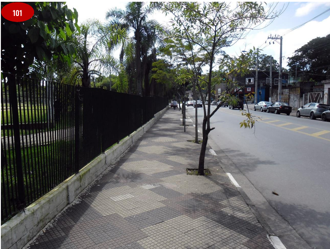
Calçamento em frente ao Parque Ecológico - Av. Nossa Senhora dos Navegantes.
