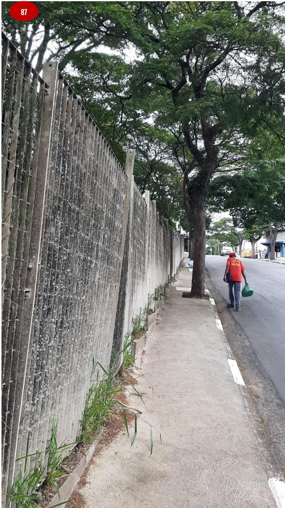
Avenida Antônio Piranga: apresenta estreitamento de passeio nas imediações do Parque do Paço, dificultando a circulação do pedestre.
