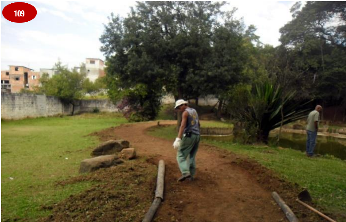
Implementação da pista de caminhada com demarcação dos percursos.
