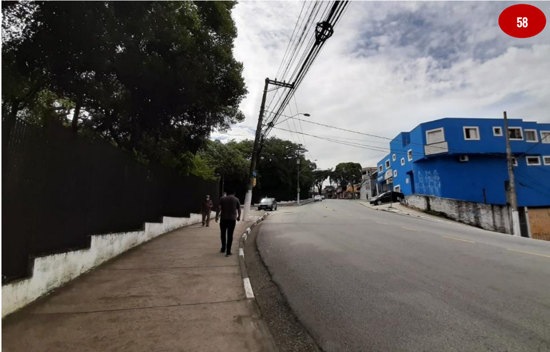
Calçamento em bom estado de conservação na R. Amélia Eugenia.
