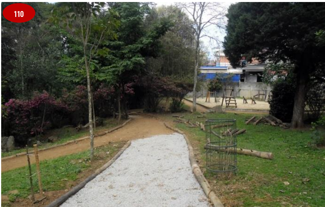
Espalhamento de pedriscos após delimitação da pista.
