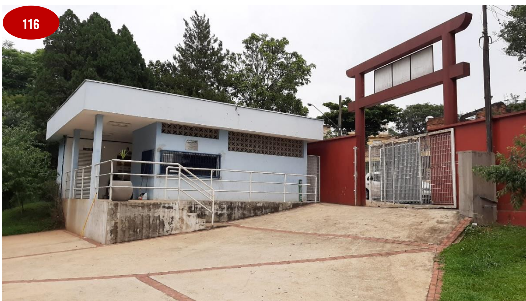
Parque Takebe: edificação de apoio.
