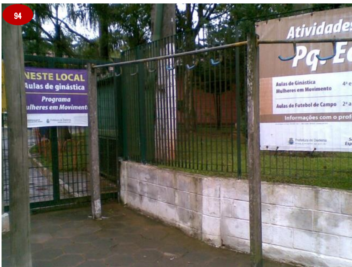
Acesso ao Parque do Eldorado antes da intervenção de 2013.
