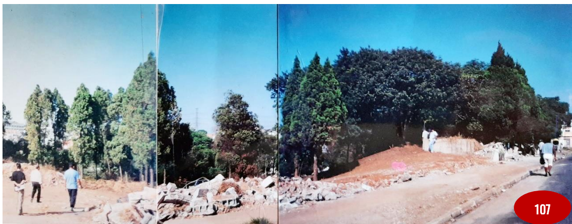
Obras para implantação do Parque Takebe – final da década de 1990. PMD – DEPARTAMENTO DE PAISAGEM URBANA.
