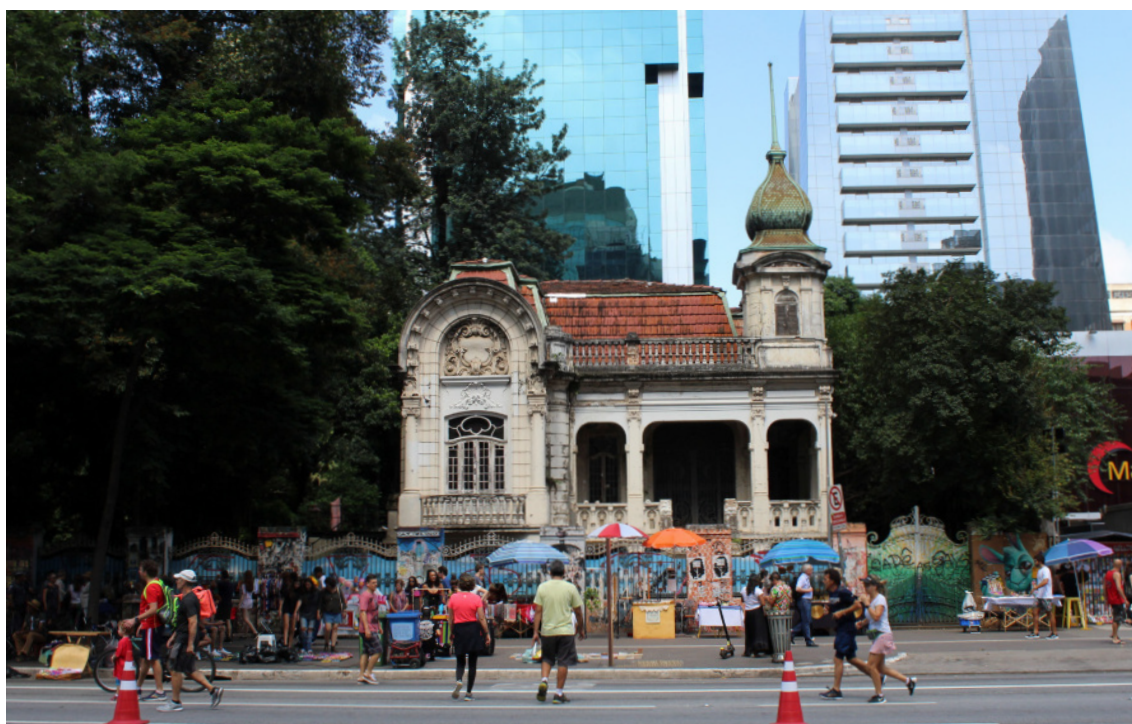
Figura 96 Fachada do Casarão Franco de Mello. Fotos: autora, março de 2019.
