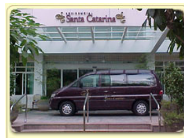
FIG.73 -fachada do residencial e van.
