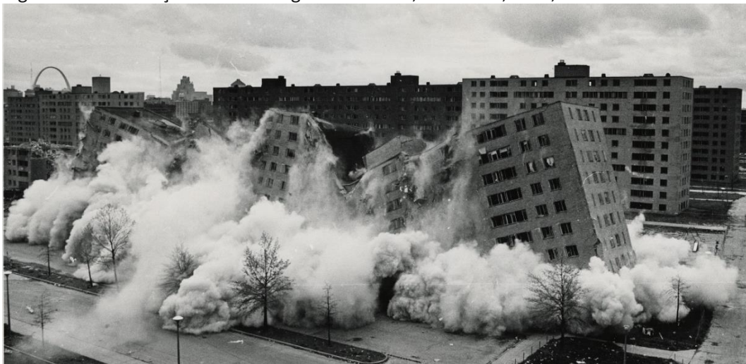
Figura 6 – Demolição do Pruitt Igoe. St. Louis, Missouri, EUA, 1972.
