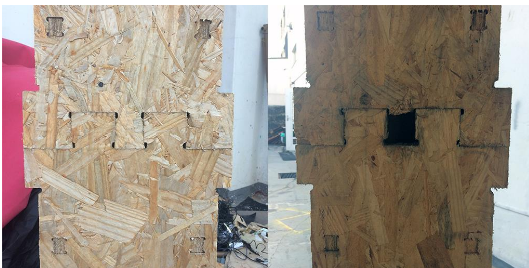
Figura 38 – Rompimento dos encaixes longitudinais.
