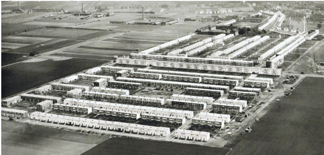
Figura 1 – Siedlung Frankfurt-Praunheim . Frankfurt, Alemanha, 1929.
