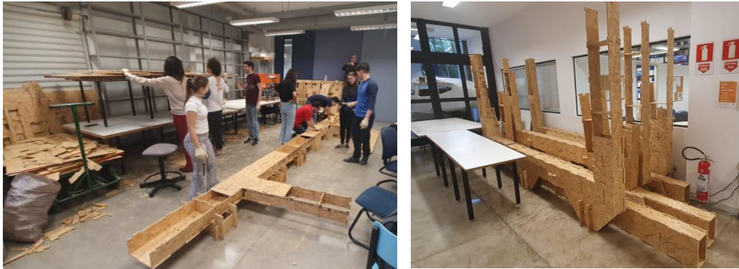
Figura 58 – Início da montagem dos pórticos em agosto de 2019.
