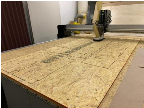
Figura 57 – Usinagem dos painéis de OSB.
