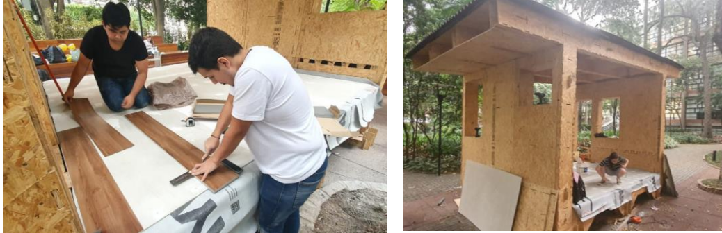
Figura 61 – Colocação do piso interno.
