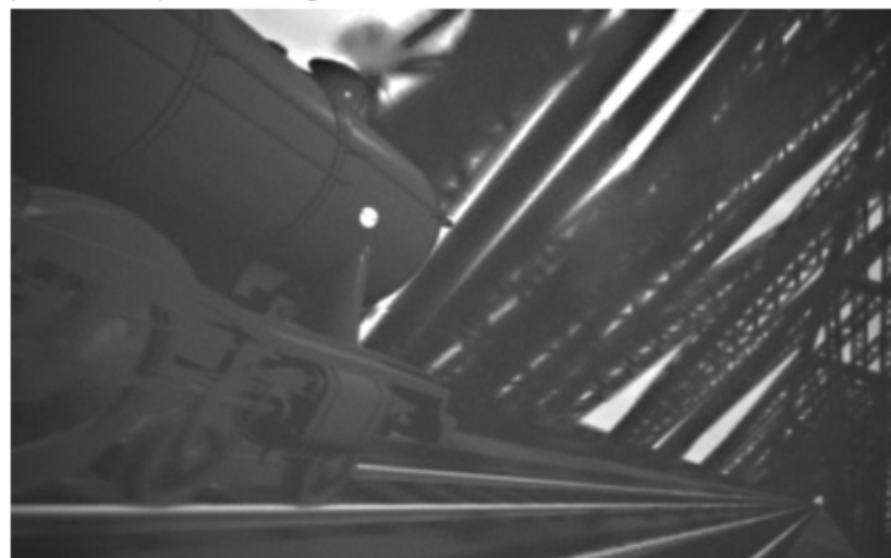
Fig. 3- Frame do vídeo “passagens do trem sobre a ponte”.
