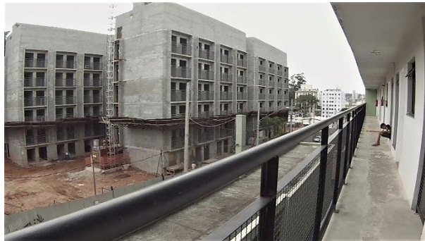
Fig. 1 – vista do corredor de acesso aos apartamentos
