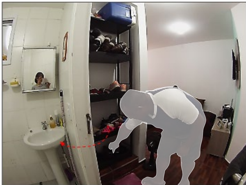
a estante-sapateira no lugar da pia, que foi reposicionada para dentro do banheiro, mantendo-se a saída original de água servida
