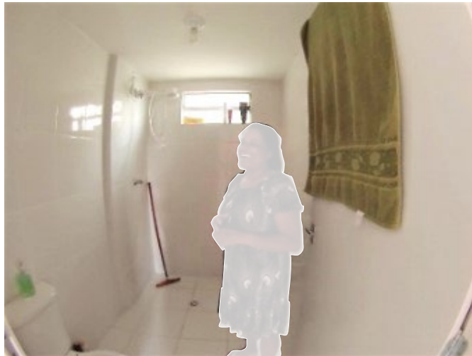
Fig. 17 – banheiro ainda sem reformas
