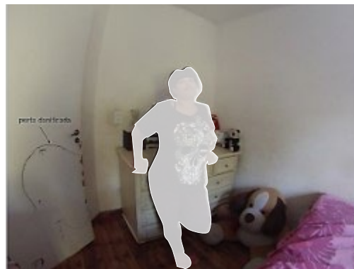
Fig. 22 – a porta danificada
