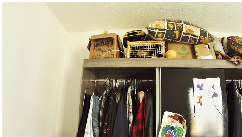
Fig. 26 – lateral do armário afastada da parede esquerda, objetos no teto
