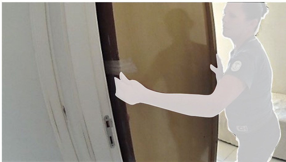
Fig. 8 – o armário invade o batente, mas não impede a porta do quarto de abrir e fechar normalmente
