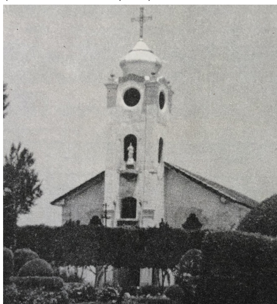
Figura 85 : Igreja Matriz de Santa Cruz da Conceição na década de 60 ainda inacabada. Nota-se que apenas a torre estava concluída, faltando acabamentos de arremate nos telhados e nos beirais. Fonte: Acervo da Paróquia Nossa Senhora da Conceição.
