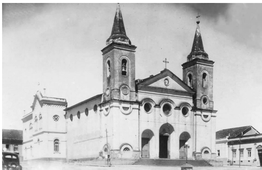
Figura 36: Igreja Matriz na década de 30 após a reforma, nota-se as novas capelas construídas na lateral da Igreja. Fonte: Acervo da Catedral Nossa Senhora das Dores.
