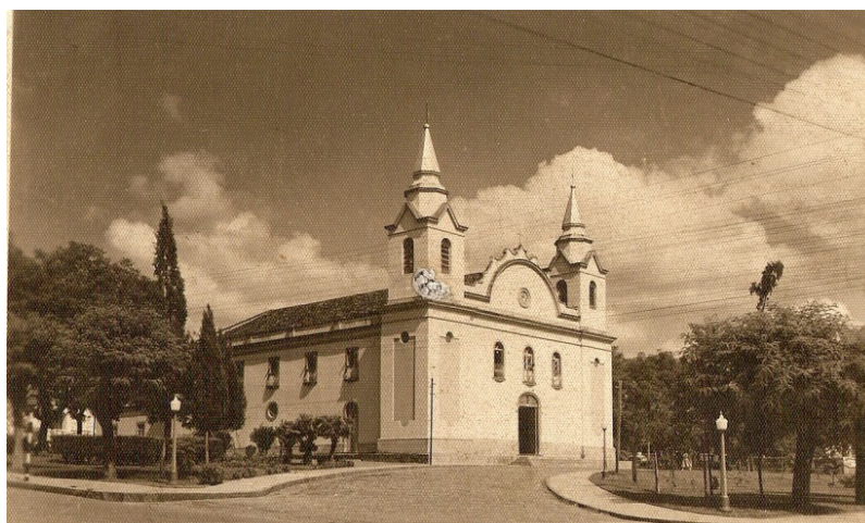
Figura 34: Igreja da Boa Morte no início do século XX, já com a reforma concluída. Fonte: Acervo da Confraria Nossa Senhora da Boa Morte e Assumpção.
