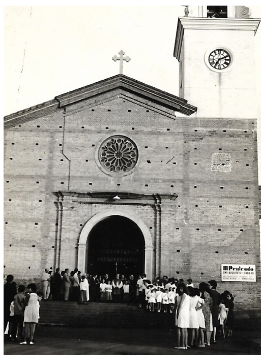
Figura 119: Fachada da Igreja Matriz já com a torre concluída, mas ainda faltando os acabamentos. Detalhe para a placa com o logotipo do escritório do arquiteto Mario Penteadó fixado junto à construção. Fonte: Acervo da Paróquia Santa Gertrudes.
