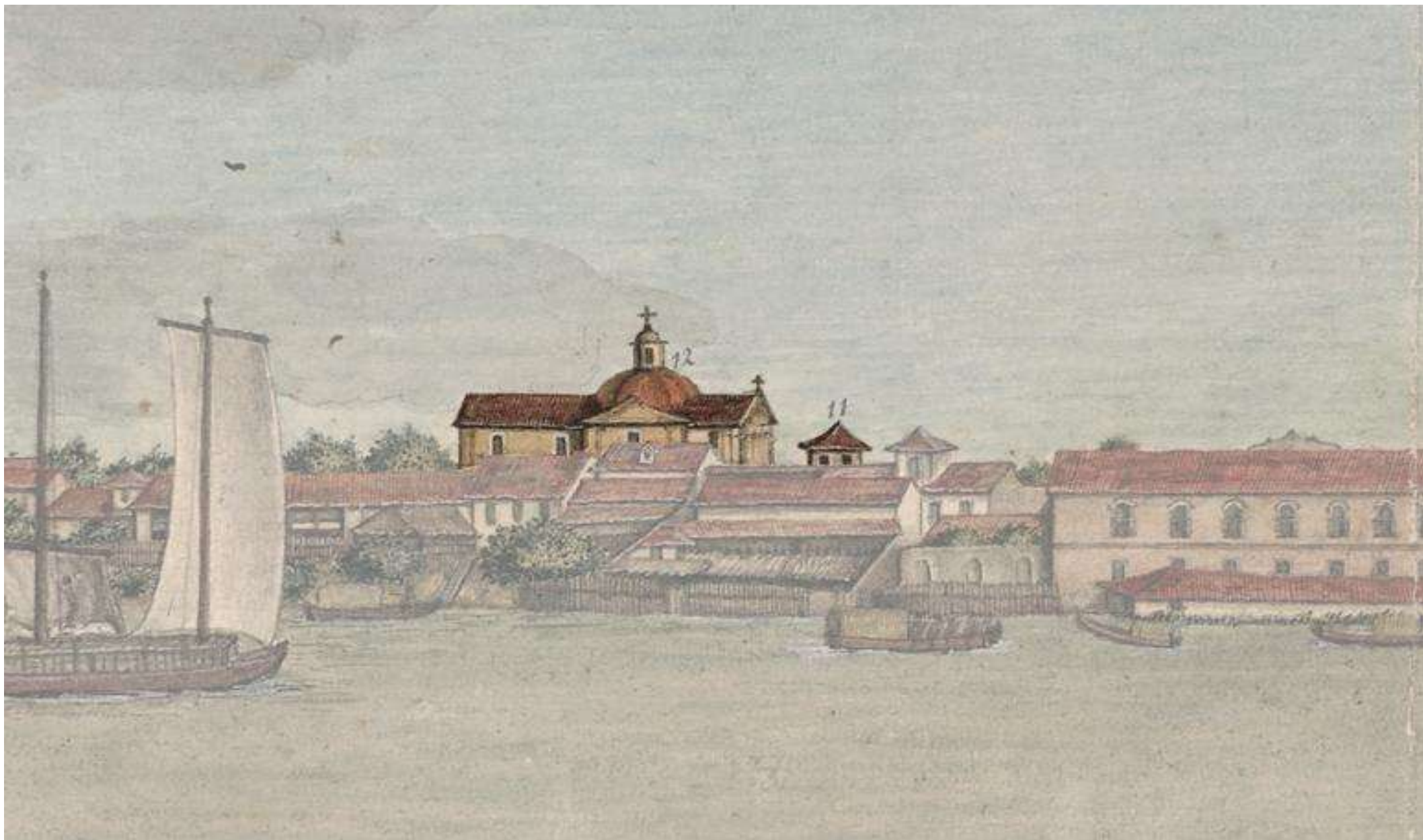
Figura 32 - Detalhe ampliado do Prospecto da Cidade de Santa Maria de Belém do Grão-Pará referentes aos edifícios indicados pelos item 11 e 12, referentes à Torre da Igreja da Misericórdia e à Igreja Matriz do bairro da Campina. Fundação Biblioteca Nacional do Rio de Janeiro.
