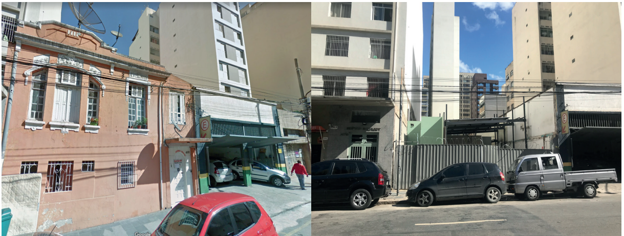
Figura 38. Comparação de imagens de 2017 da “Hospedaria Jaguaribe” e obra em andamento em 2019 para construção do empreendimento Hello Higienópolis (Rua Jaguaribe). Fonte: Google Earth e levantamento próprio.
