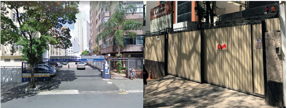
Figura 42. Comparação de imagens de 2010 de lote com estacionamento e obra em andamento em 2019 para construção do empreendimento Condomínio Gallipoli (Avenida Angélica). Fonte: Google Earth e levantamento próprio.
