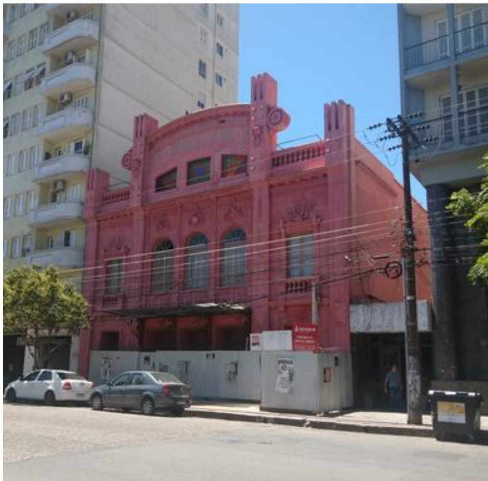
Figura 27: Teatro Sete de Abril e calçamento asfáltico interrompido em sua fachada.
