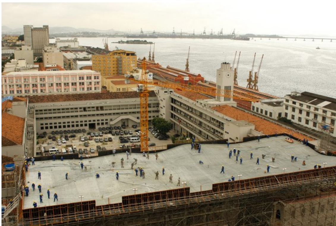
Figura 195. Concretagem do Museu de Arte do Rio. Fonte: Acervo Jacobsen Arquitetura.
