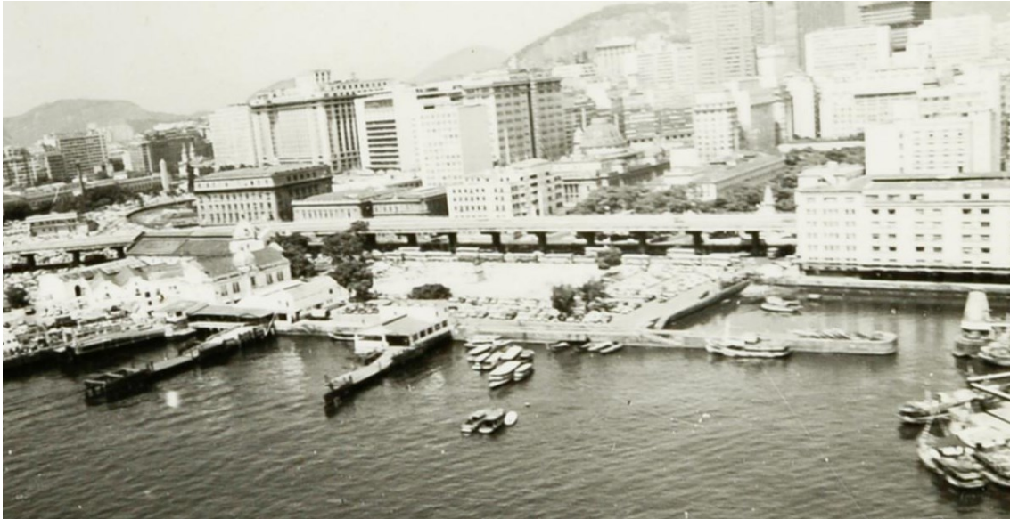
Figura 207. Elevado da Perimetral, em 1962. Fonte: Acervo Brasileira.
