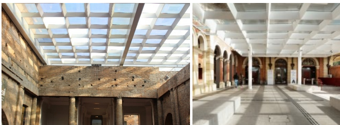
Figura 50. Pinacoteca do Estado de São Paulo. Detalhe da cobertura. Fonte: Acervo da autora.
