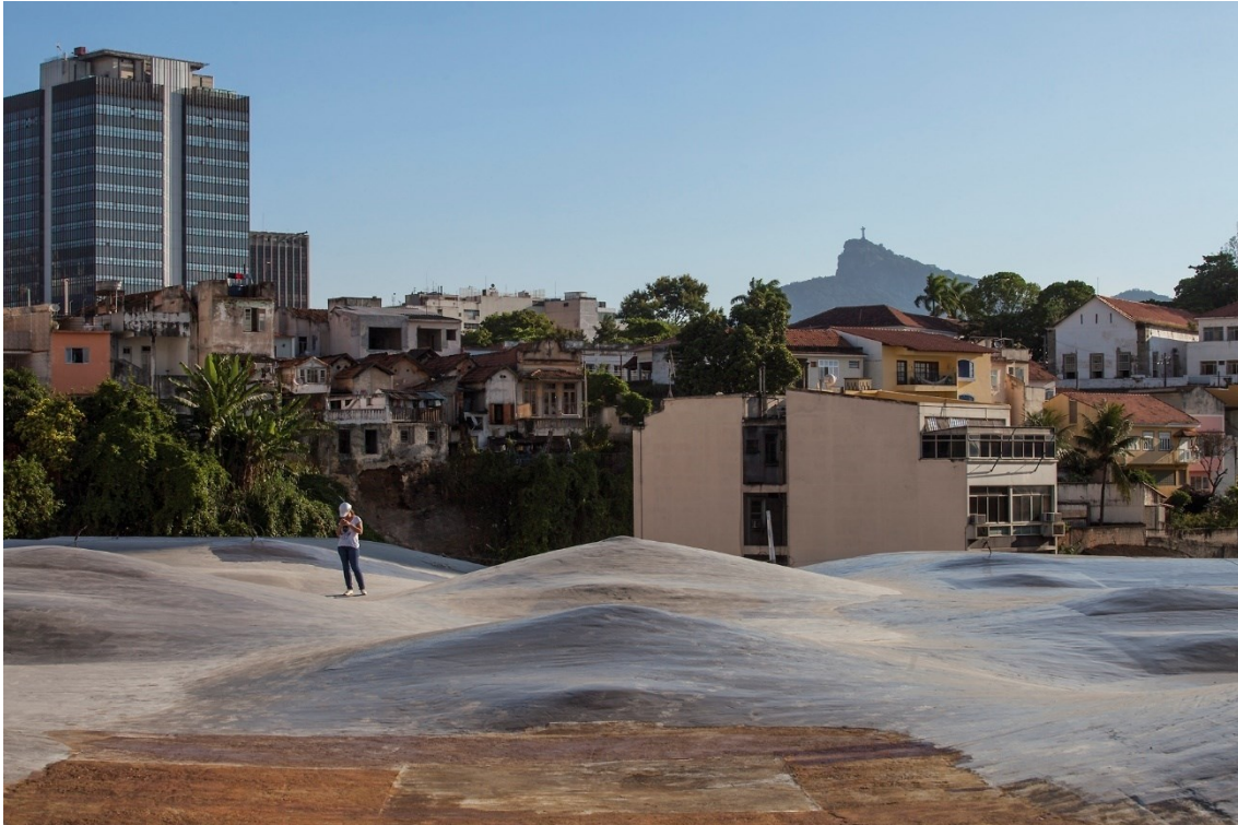
Figura 196. Construção da cobertura do MAR. Fonte: Acervo Jacobsen Arquitetura.
