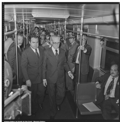
128 e 129 Visita do Presidente General Ernesto Geisel às obras da Estação Liberdade do Metrô, junto ao prefeito Miguel Colassuono e Plínio Assman [Arquivo Público do Estado de São Paulo]
