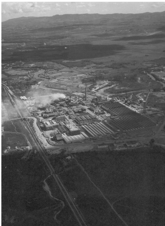
Figura 20. Panorama de implantação da Nitro Química em seus primeiros anos de funcionamento. Nele podemos observar ampla dimensão da planta industrial, assim como um amplo conjunto de áreas livres que serão ocupadas especialmente por vilas operárias.
