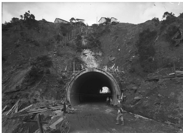
Figura 40. Construção da Rodovia Anchieta, década de 1950.
