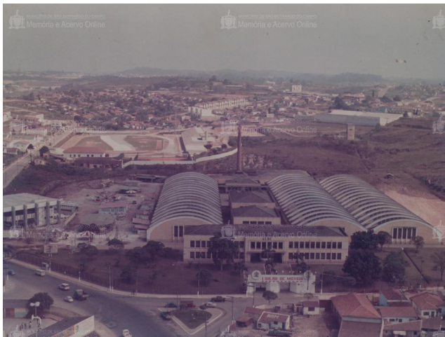
Figura 42. Edificações da tecelagem Elni, década de 1970.
