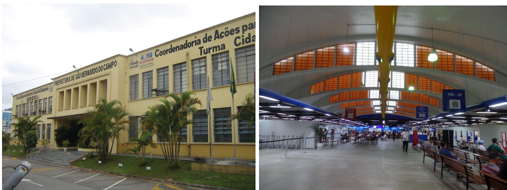
Figura 43. Edifícios ocupados atualmente pela Secretaria de Desenvolvimento Social e Poupatempo.
