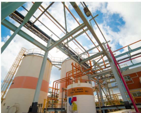
Figura 28. Situação dos edifícios por volta de 2009, quando começaram a ser demolidos (sup.). Novos equipamentos da Nitro Química, anos 2000 (inf).
