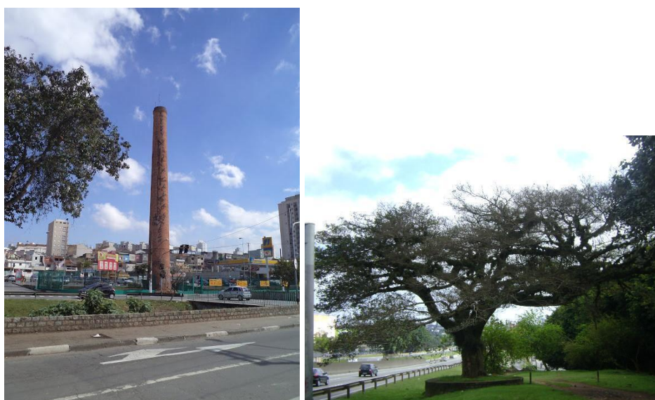
Figura 53. Chaminé da avenida Pery Ronchetti (esq.). Árvore dos Carvoeiros (dir.). São Bernardo do Campo.
