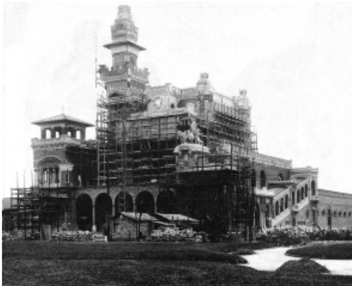
Palácio das Indústrias em construção ( Diário de S.Paulo , 24 jan. 2004, p. 21)
