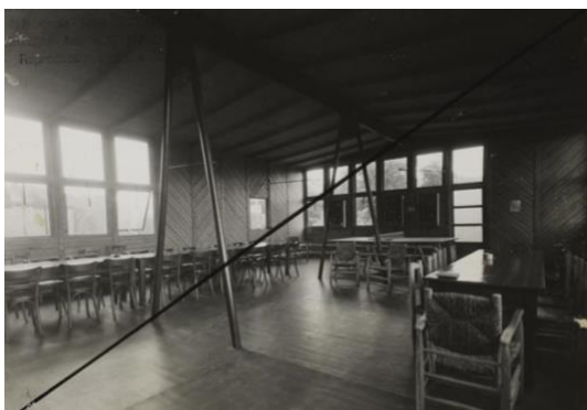
Figura 17 - Módulo de refeitório para Société centrale des alliages légers (SCAL) em Issoire. Fonte: ADAGP, Centre Pompidou, 230j747.
