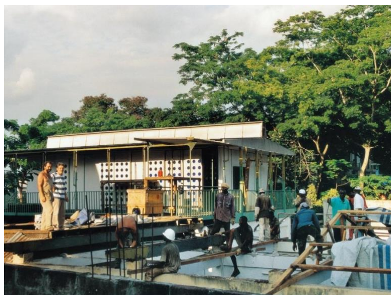
Figura 32 - Foto da desmontagem dos protótipos de Brazzaville, o protótipo maior desmontado revelando a área ocupada sob os pilotis. Fonte: Galerie 54. https://galerie54.com/
