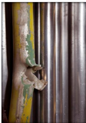
Figura 33 - Buraco de Bala pós-restauro em um dos protótipos de Brazzaville. Fonte: (O'DAY, 2009)
