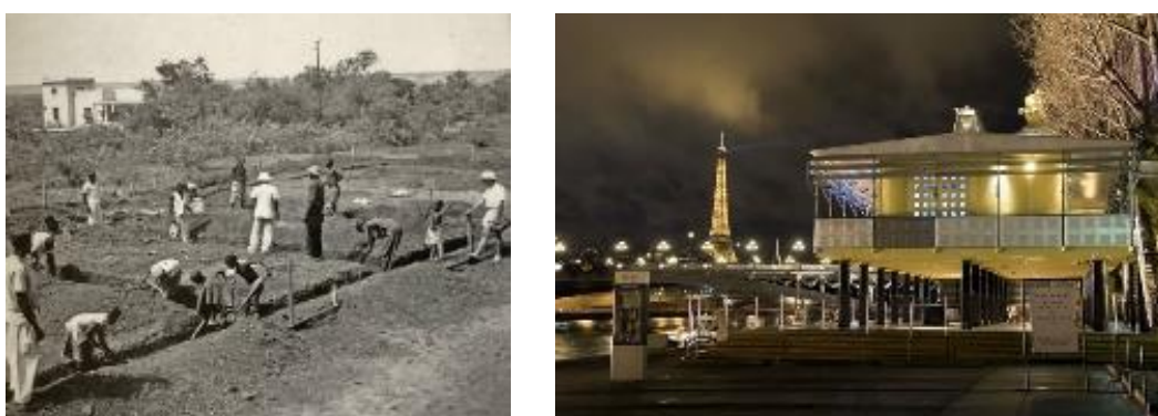
Figura 1 – À esquerda, imagem do canteiro de construção do embasamento da Casa Tropical enviada à cidade de Niamey em 1949 (Fonte: CINQUALBRE, 2009). À direita, imagem da Casa Tropical em exposição na cidade de Paris em 2006 (Fonte: www.galerie54.fr )
