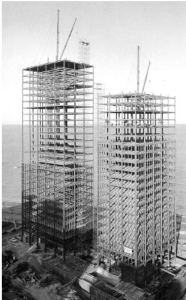
Figura 27- Foto da construção das torres da Lake Shore Drive.
