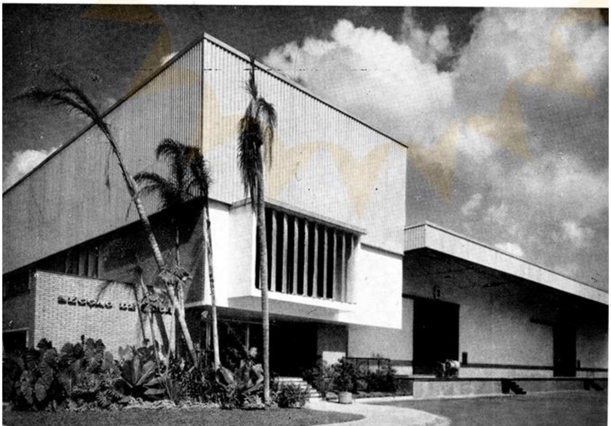
Figura 46- Fachada lateral do edifício da Lion s/a .
