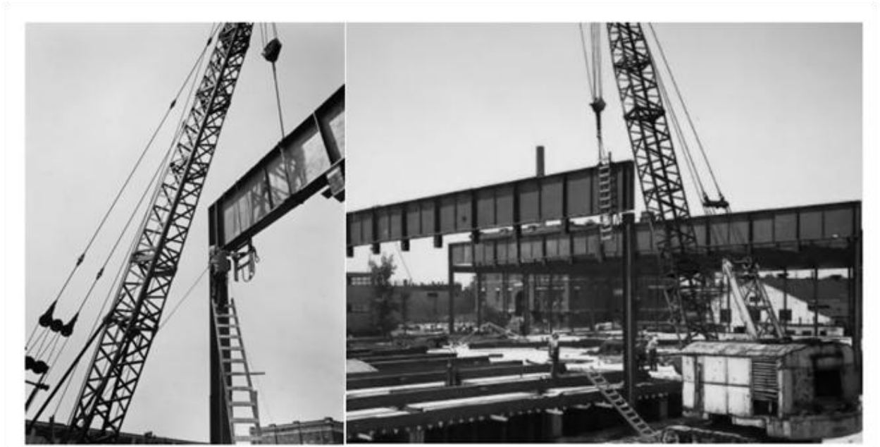
Figura 30- Fotos do processo de montagem das vigas que o engenheiro estrutural de Mies, Frank Kornacker, tirou em 1952.
