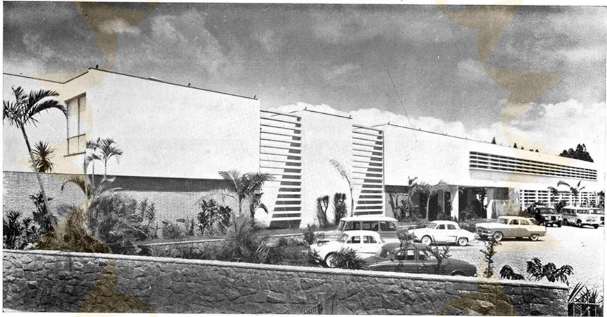
Figura 60- Fachada do edifício da Administração da Willys Overland em São Bernardo do Campo.
