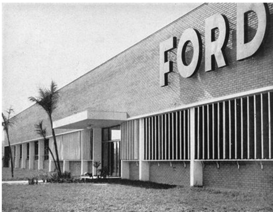
Figura 55- Fachada Principal do edifício de escritórios e refeitório da Fundação de Motores Ford em Osasco.
