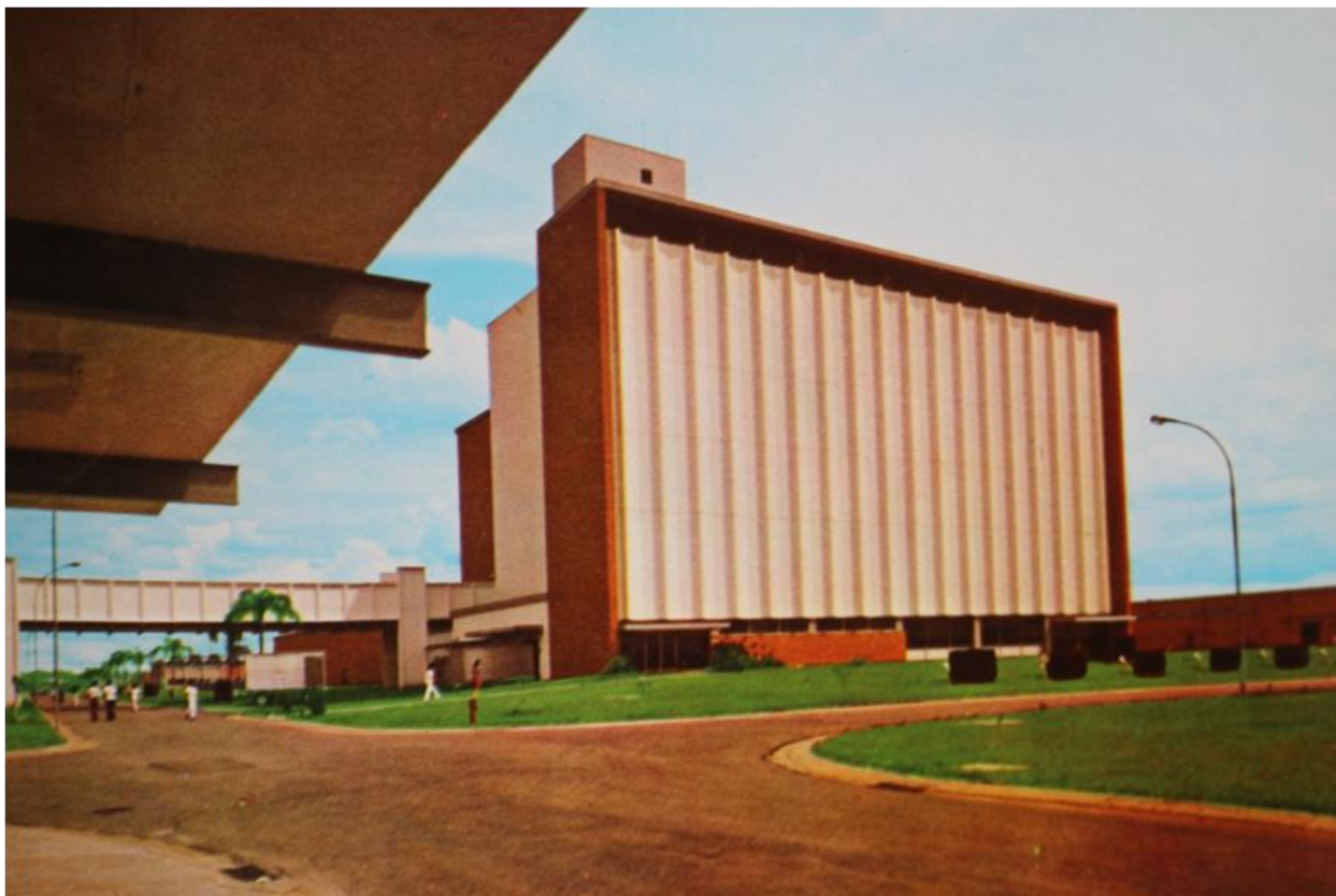
Figura 71- Edifício Principal da KODAK.
