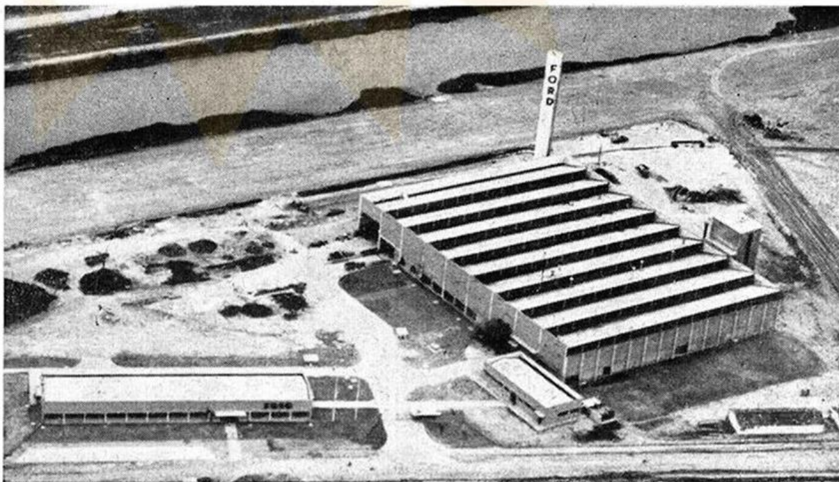
Figura 54- Vista área da Fundação de Motores Ford em Osasco.
