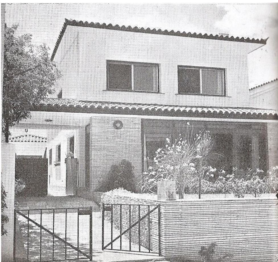
Figura 48 - Fachada da residência anterior à reforma.
