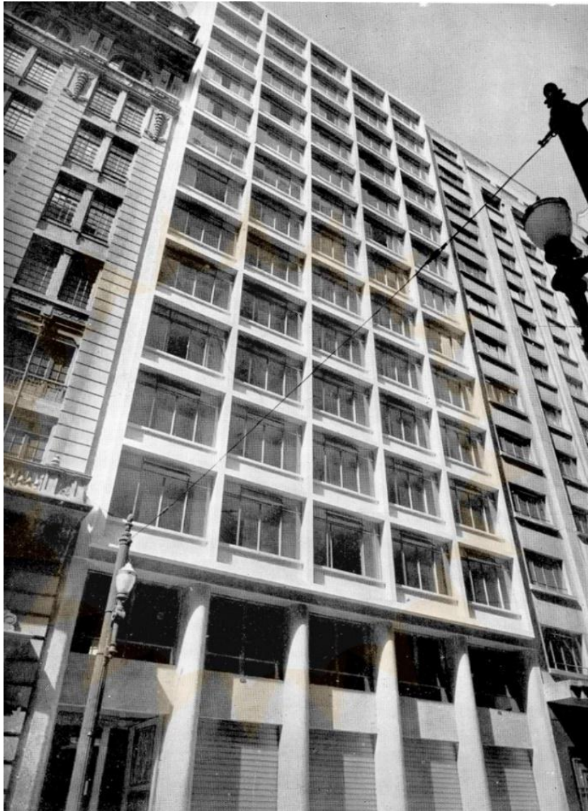
Figura 6 - Edifício comercial projetado e construído pela Construtora Munhoz & Lara Ltda. Fonte: Revista Acrópole, maio de 1950.
