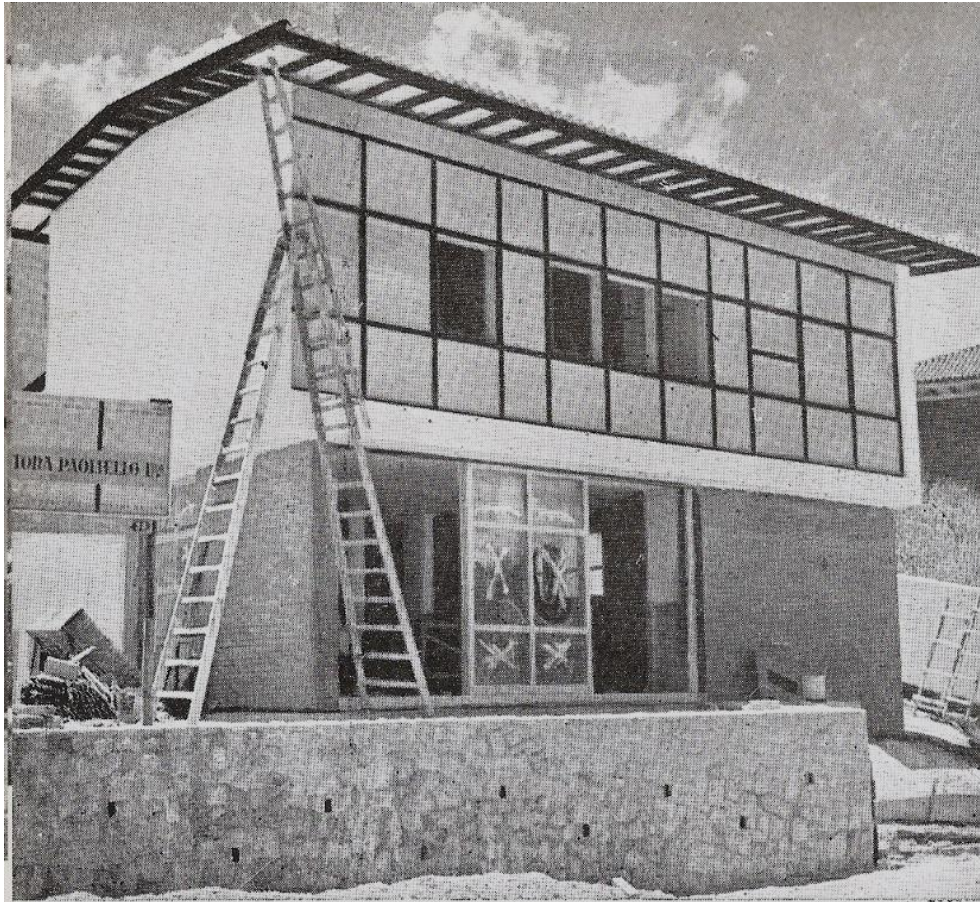
Figura 15 - Residência do Sr. José Niccolini na Rua Silvio Portugal, 38, no bairro do Sumaré. A placa de identificação da Construtora Paoliello Ltda. pode ser vista no meio do lado esquerdo da fotografia. Fonte: Revista Comemorativa de 07 anos de atuação da Construtora Paoliello Ltda, 1956, p. 31.
