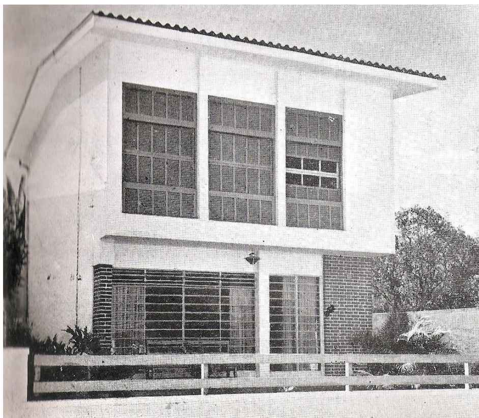
Figura 26 - Fachada da Residência do Senhor Tito M. Nogueira de Noronha no bairro do Itaim, projetada por Rodolpho Ortenblad Filho e Arnaldo Paoliello.
