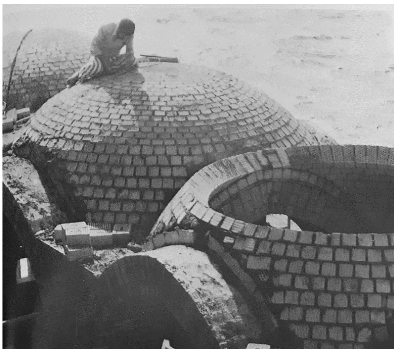
Figura 66: Cúpulas em construção, projeto do arquiteto egípcio Abdel Wahed El Wakil, década de 1980 (fonte: Spazio e Società, n. 29, 1985., p. 95).
