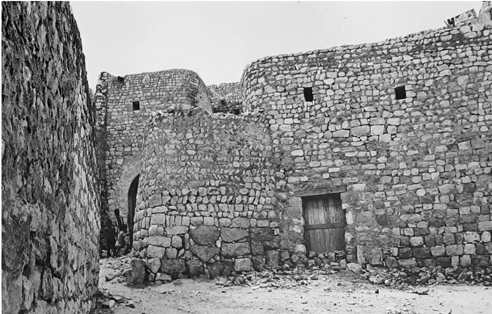
Figura 67: Aldeia fortificada berbere de Zraoua, Tunísia (fonte: Spazio e Società, n. 20, 1982, p. 13).
