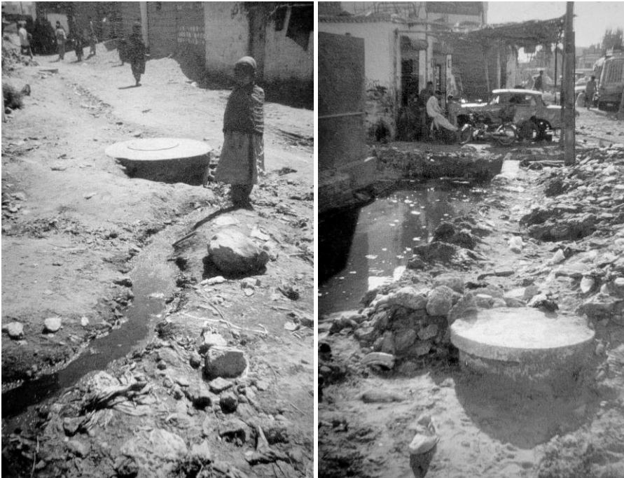
Figuras 47 e 48: Tampas de bueiros dos esgotos construídos pelos próprios habitantes no squatter de Orangi, em Karachi, Paquistão, do texto de Fred Pierce (fonte: Spazio e Società, n. 77, 1997, p. 46 e 48).
