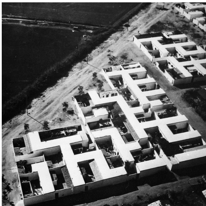
Figura 3: Foto de 1954 das casas com pátio projetadas para a área de Carrières Centrales , na periferia Casablanca, por Michel Écochard. Fonte: DAINESI, 2019, p. 311.
