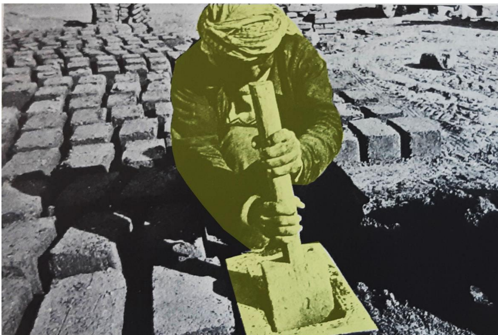
Figura 51: A preparação dos tijolos, Egito (fonte: Spazio e Società, n. 17, 1982).
