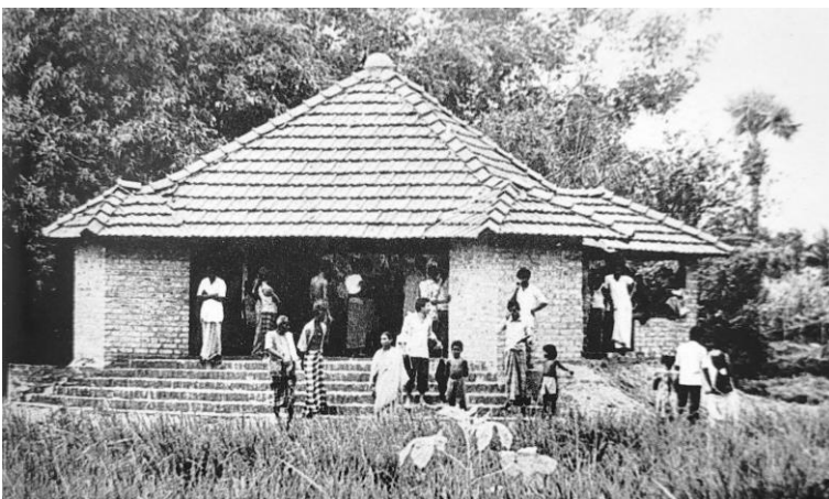
Figura 127: Centro de maternidade e infância para a comunidade rural Bagnan Village, no estado indiano de West Bengala, em 1979. Promovido pela UNICEF de Calcutá e pelo Departamento de Assistência Social do governo de West Bengala (fonte: Spazio e Società, n. 38, 1987, p. 127).
