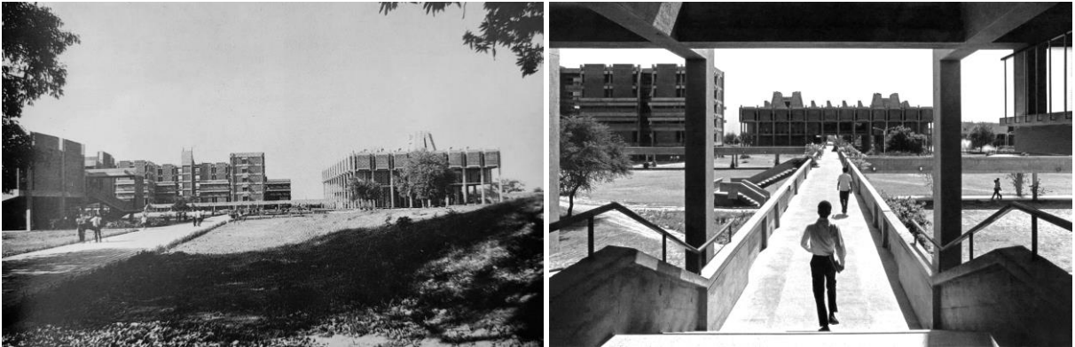
Figuras 123 e 124: Vista do projeto do arquiteto Achyut Kavinde, Indian Institute of Technology, em Kanpur ( Spazio e Società , n. 38, 1987, p. 117). Imagem do mesmo Instituto exibida na exposição do MoMA The Project of Independence: Architectures of Decolonization in South Asia, 1947–1985 (2022). Crédito da foto: Kavinde Archives, disponível em < https://www.archdaily.com/981654/moma-exhibition-explores-the-architectures-of-decolonization-in-south-asia?ad_medium=gallery >. Acesso em: 11 fev. 2023.
