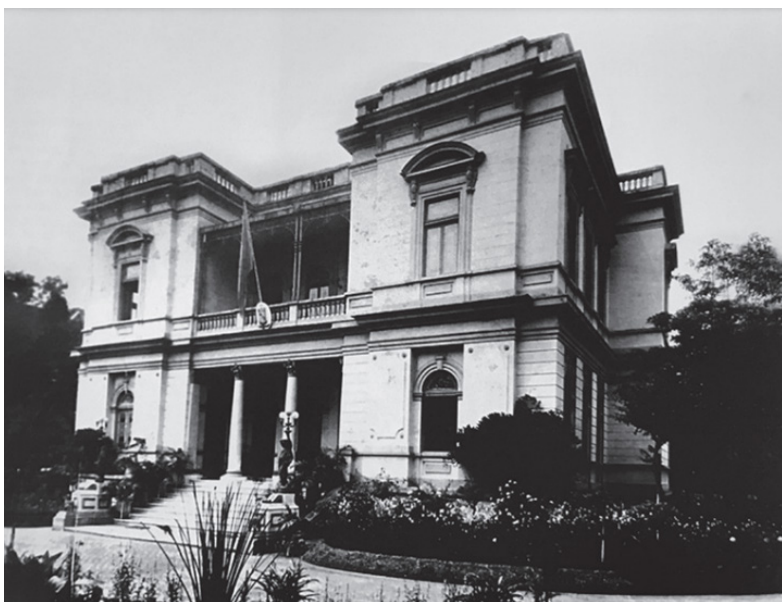
Figura 1.7 Palácio Episcopal ou Palácio São Luis, onde era o antigo o palacete-sede da chácara do Barão de Souza Queiróz (localizado na rua São Luiz nº 02). A residência pouco sofreu alterações em sua fachada, já em estilo neoclássico, a não ser na instalação do brasão da arquidiocese (na entrada principal). Autor: desconhecido. Acervo: Arquivo da Cúria Metropolitana de São Paulo.
