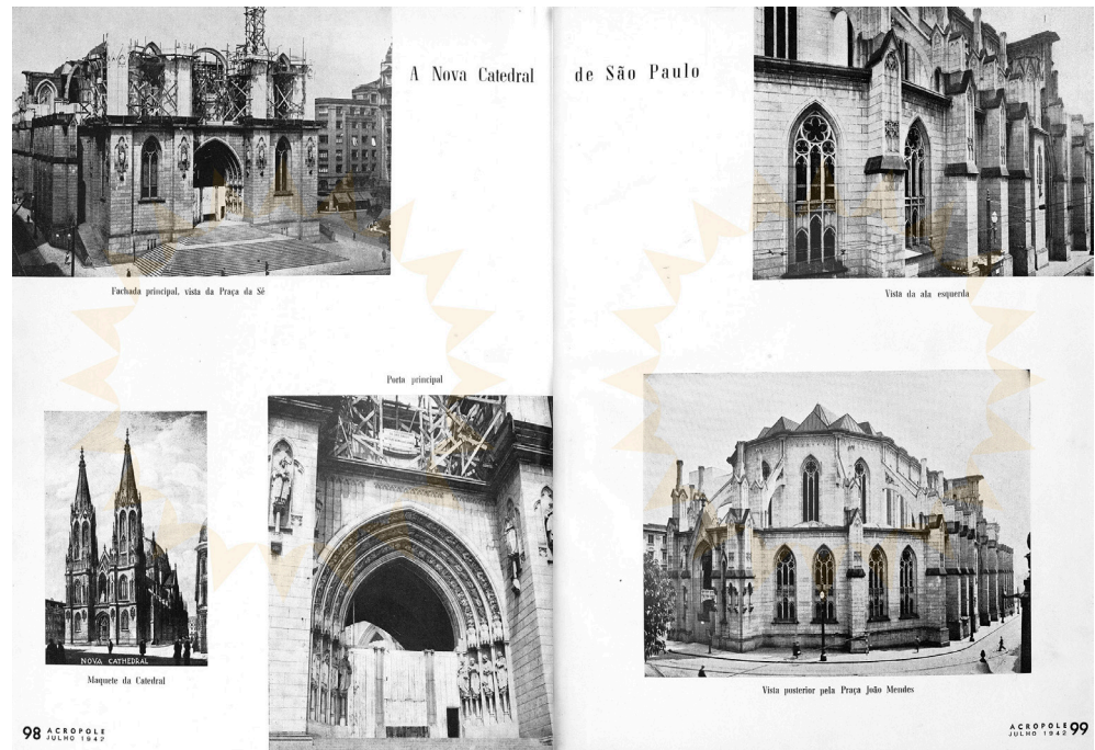
Figura 2.4 - Artigo da revista Acrópole apresentando aspectos da construção da Catedral da Sé onde se observa que nas vésperas do IV CEN a catedral apresentava-se com o primeiro nível de fachadas finalizadas, tendo a cobertura do altar-mor finalizado [onde se instalou o altar provisório] estando ao ar livre a nave central [local onde os fiéis participavam das celebrações]. Como visto, também era comum a instalação de um altar provisório na escadaria do portal principal da catedral, onde a praça da Sé assumia como o corpo do templo. Fonte: Revista Acrópole , São Paulo, pp. 98-104, jul. 1942. Acervo: Biblioteca FAU/USP.
