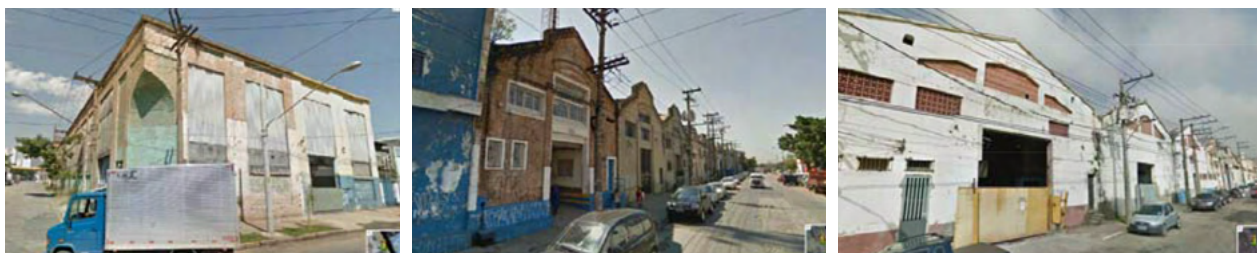
Imagens 54: Edifício 17, para o qual foi indicada sua manutenção
