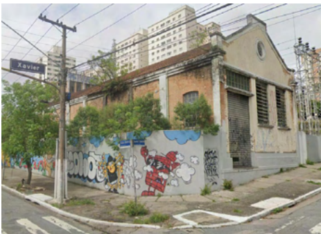
Imagem 25: Subestação de distribuição de energia.
