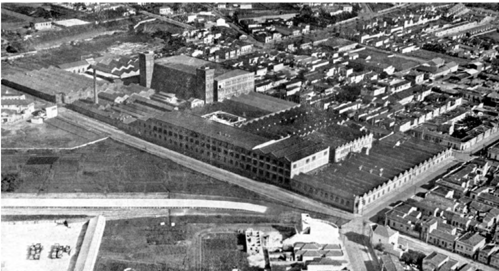
Imagem 02: Conjunto industrial do Cotonifício Crespi, localizado no bairro da Mooca, e ocupação residencial/comercial no seu entorno. c 1930/1940
