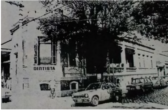
Imagem 11: Imóvel residencial na Rua da Mooca, 1978.
