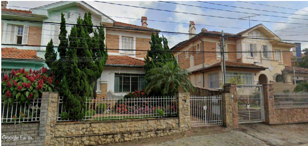
Imagem 24: Conjunto de casas geminadas na Rua Jorge Moreira.
