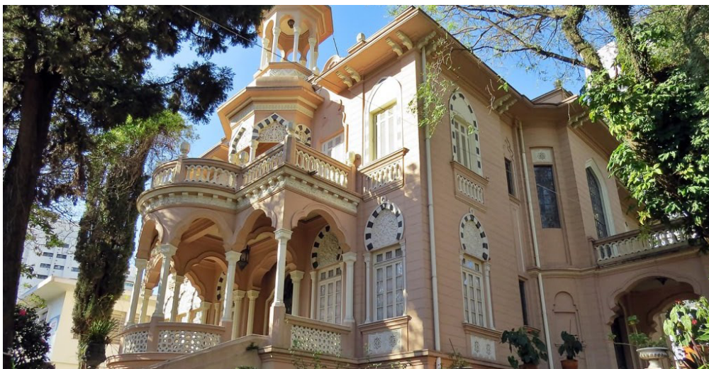
Imagens 13, 14 e 15: Casarões da família Jafet no Ipiranga. Localizados, em sentido horário, na Rua Bom Pastor 730, 798 e 801.
