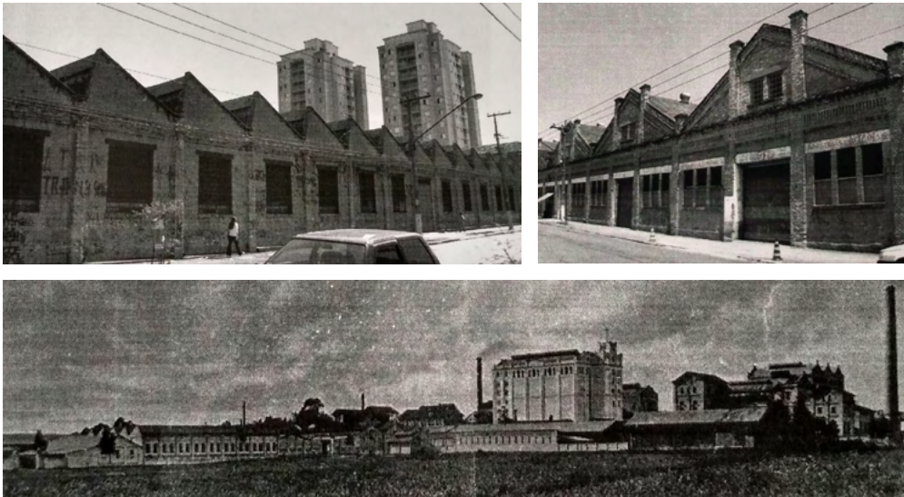
Imagem 34: Galpões do conjunto da Casa Vanordem. s/d. (sup. esquerdo).
