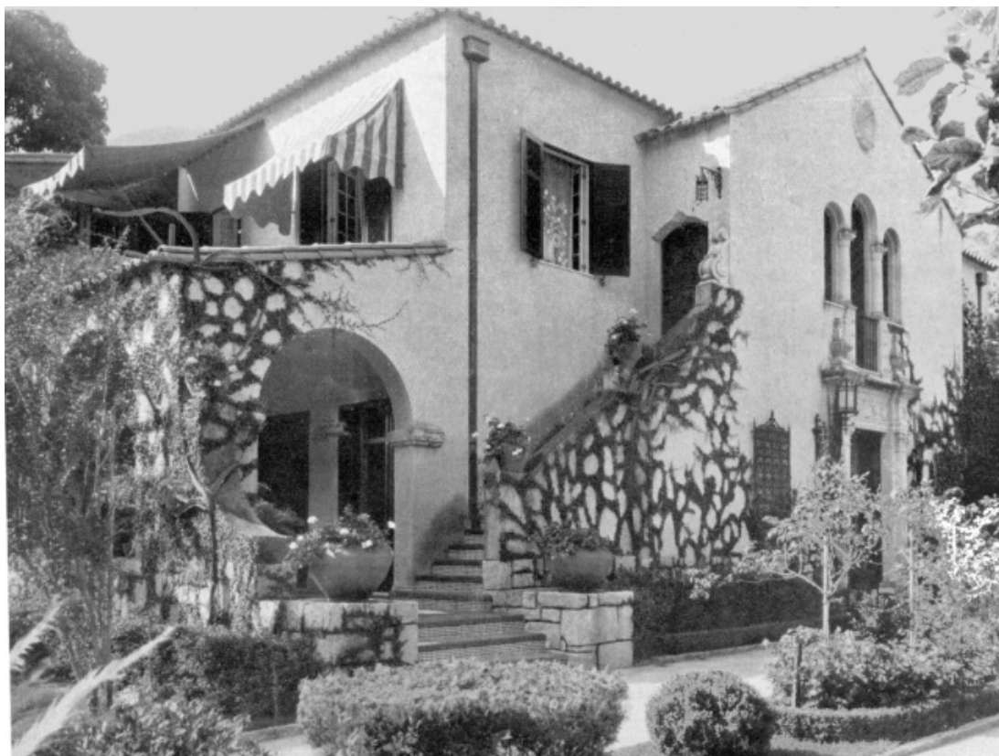
Figura 15: Residência da Sra. Adelaide Daudt de Oliveira, um de dois projetos do arquiteto no Cosme Velho, em parceria com Fernando Valentim. 1928. Fonte: PINHEIRO, 2011:188.
