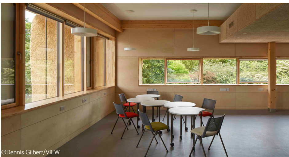
Figura 79 – Enterprise Centre, da University of East Anglia | Sala com Módulos de Revestimento
