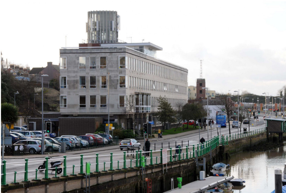
Figura 86 - Edifício de Escritórios Existente | North Quay, Weymouth
