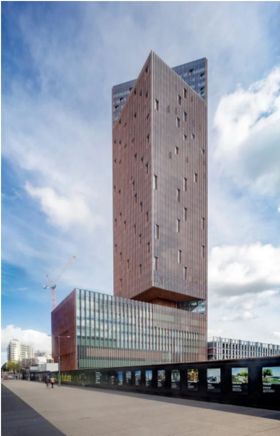
Figura 64 – Esquerda | Manhattan Loft Gardens - SOM | Fachadas sul e oeste Fonte: Archilovers
