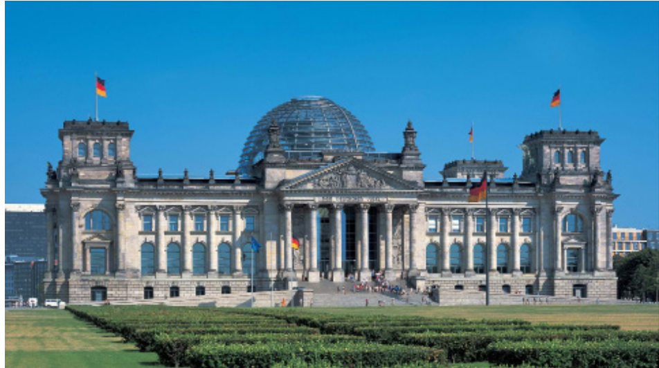
Figura 53 – Edifício do Parlamento Alemão
