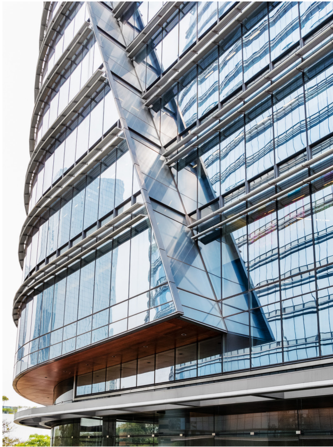
Figura 149 – São Paulo Corporate Towers | Detalhe da Fachada Fonte: Aftalo/Gasperini Arquitetos
