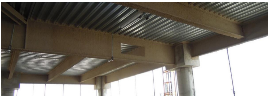
Figura 169 – São Paulo Corporate Towers | Estrutura
