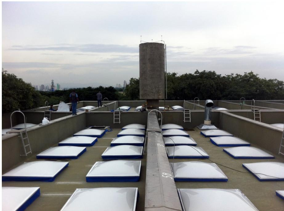
Figura 35 Vista da cobertura após a campanha de recuperação e reimpermeabilização da laje, ocorrida entre 2013 a 2015. Foto: Rodrigo Vergili
