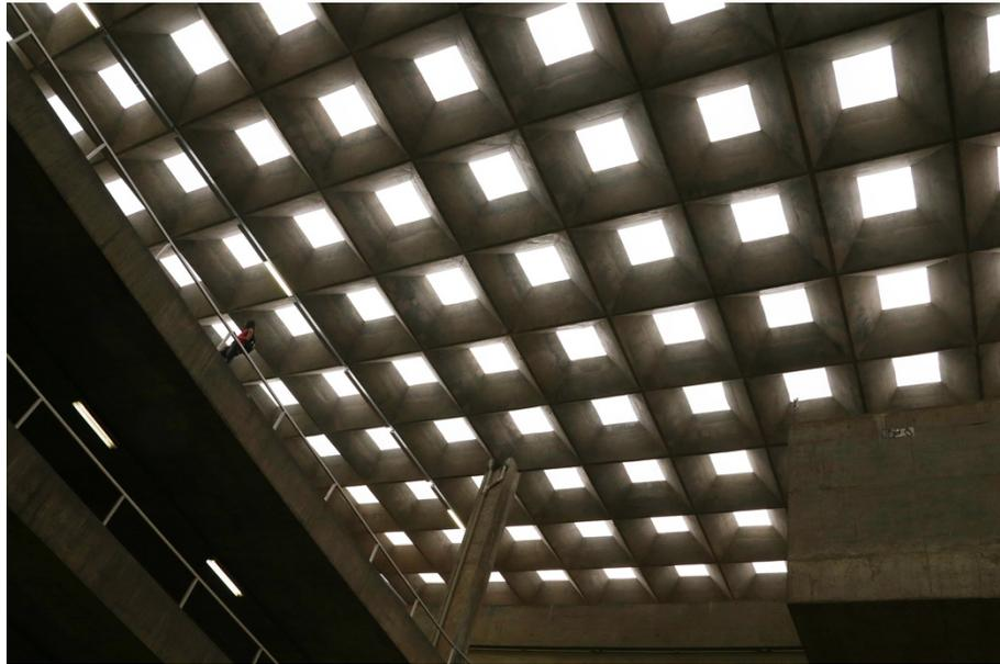
Figura 2 Cobertura em concreto aparente do edifício Vilanova Artigas. Marcos Santos. USP Imagens.
