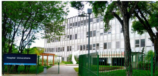
Figura 21 - Fachada do HU USP com brises de alumínio (registro realizado em 29/11/2021)
