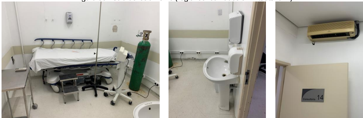
Figura 53 - Sala de isolamento (registros realizados em 28/06/2022)
