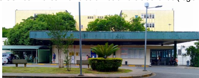
Figura 23 - Fachada do HU USP com revestimento cerâmico amarelo ao fundo (registro realizado em 29/11/2021)
