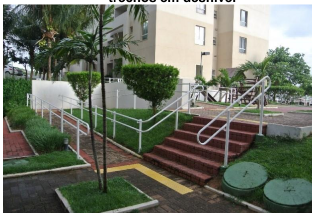
Figura 30: Rampa e escada com corrimãos, mas com ausência de guarda corpos em trechos em desnível
