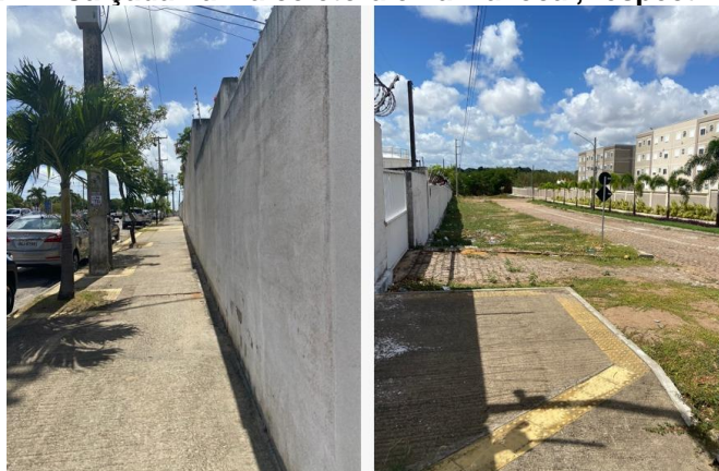
Figura 27: Calçada na via coletora e na via local, respectivamente
