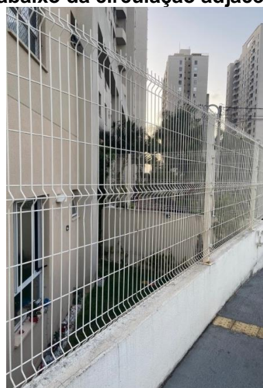
Figura 35: Apartamento com nível de piso abaixo da circulação adjacente
