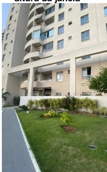
Figura 34: Muro de divisa do jardim na altura da janela
