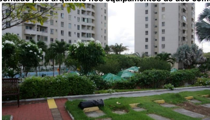
Figura 32: Vista a partir da entrada do edifício, com destaque para o "núcleo" verde apontado pelo arquiteto nos equipamentos de uso comum
