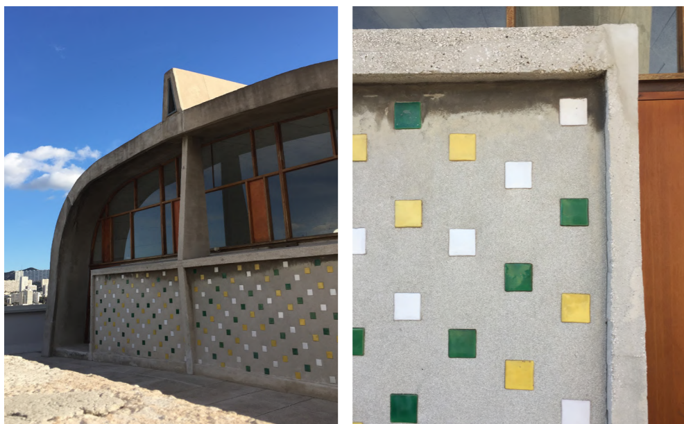
FIGURA 58: Toit-Terrasse. Detalhe das pastilhas coloridas aplicadas sobre o concreto, do ceramista francês Philippe Sourdive. Fonte: A autora.
