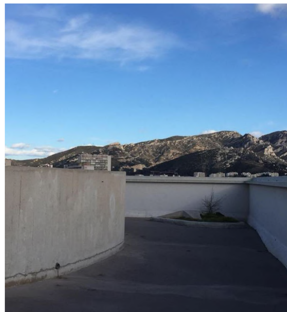
FIGURA 59: Toit-Terrasse. Ginásio e pista de corrida. Fonte: A autora.
