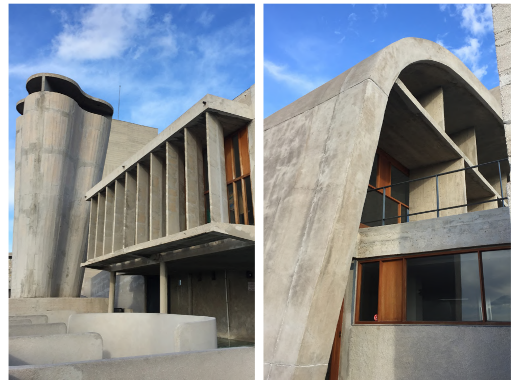
FIGURA 57: Toit-Terrasse. Torre de ventilação, creche e ginásio. Fonte: A autora.
