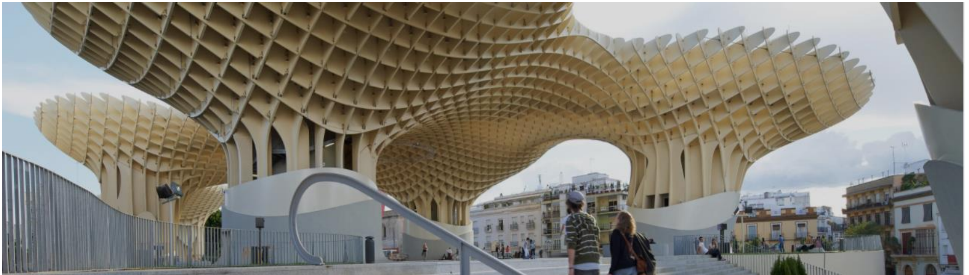
Figura 77: Metropol Parasol - vista externa. Fonte: Arup (2019) adaptado pela autora (2021).
