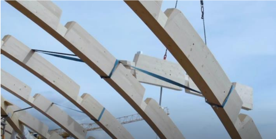
Figura 111: Montagem in loco estrutura de madeira. Fonte: Lehmann (2020) adaptado pela autora (2021).
