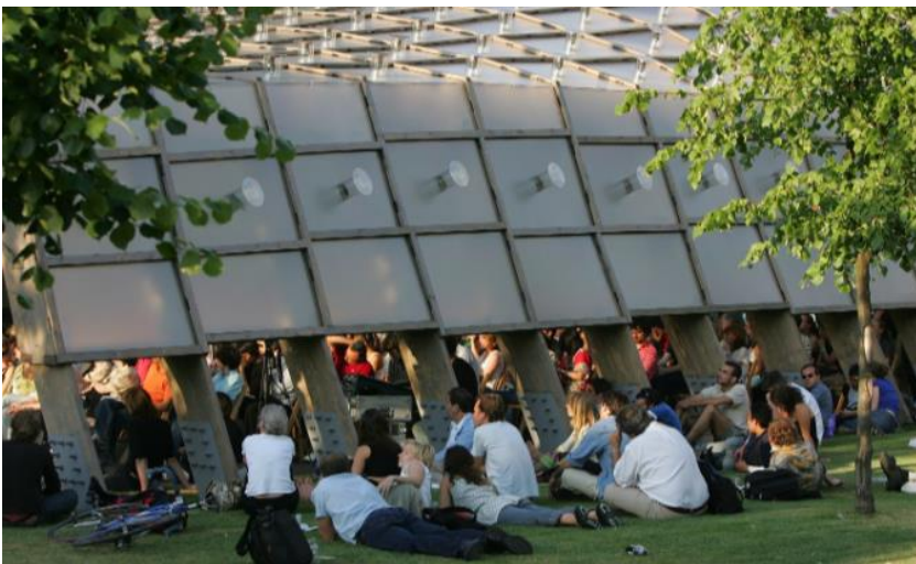
Figura 62: Pavilhão Serpentine - vista externa. Fonte: Afaconsult (2019) adaptado pela autora (2021).
