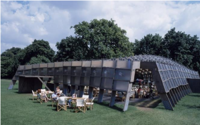
Figura 60: Pavilhão Serpentine - vista externa. Fonte: Afaconsult (2019) adaptado pela autora (2021).
