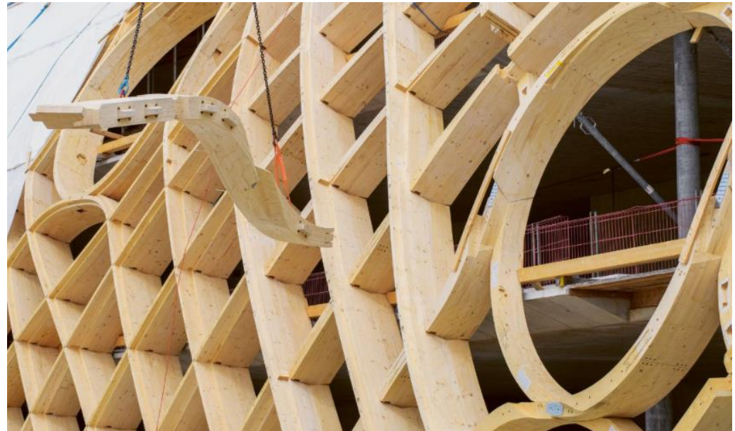
Figura 115: Içamento das peças de madeira. Fonte: Lehmann (2020) adaptado pela autora (2021).
