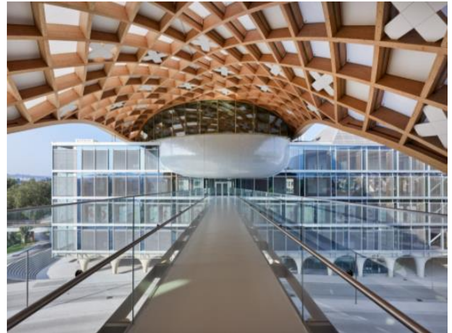
Figura 116: Passarela entre os edifícios Swatch Omega. Fonte: Architonic (2020) adaptado pela autora (2021).
