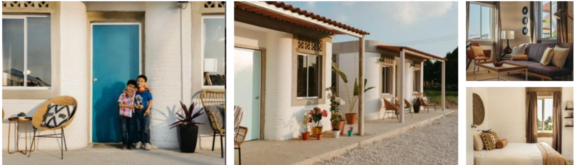
Figura 157:Fotos externas e internas: casa impressa em 3D com concreto. Fonte: ICON (2021) adaptado pela autora (2021).
