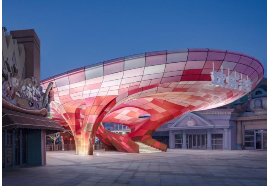
Figura 159: Portal de entrada, de plástico, impresso em 3D. Fonte: Archdaily (2021) adaptado pela autora (2021).
