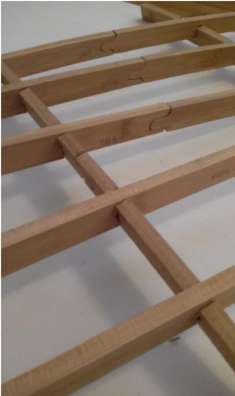
Figura 311: Peças de bambu laminado: encaixes perpendiculares e longitudinais. Fonte: Autora (2019).
