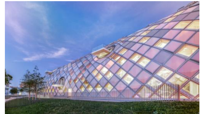
Figura 108: Edifício da Swatch. Fonte: Architonic (2020) adaptado pela autora (2021).
