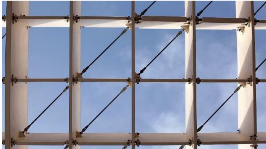
Figura 84: Detalhe da estrutura - Metropol Parasol. Fonte: Archdaily (2019) adaptado pela autora (2021).
