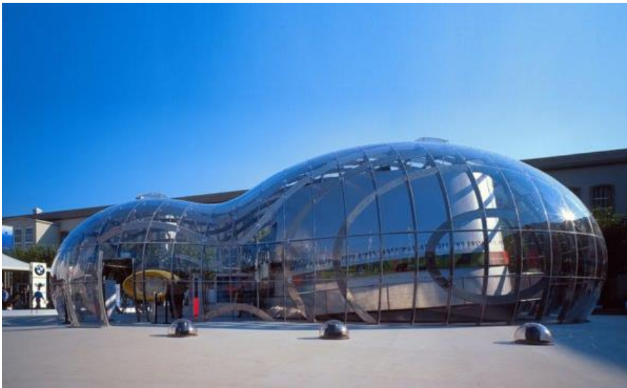
Figura 146: Vista externa: edifício 'The Bubble'. Fonte: Franken (2020) adaptado pela autora (2020).
