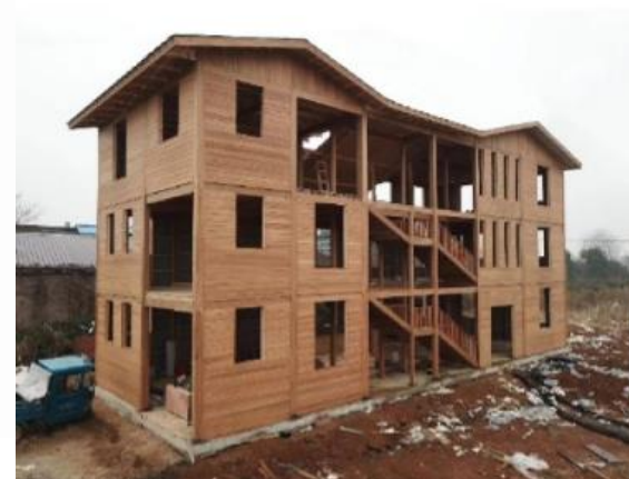
Figura 47: Construção de bamboo laminado: Nanjing Forestry University Fonte: Chen et al. (2020)
