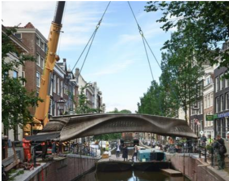
Figura 158: Ponte de metal impressa em 3D. Fonte: Archdaily (2021) adaptado pela autora (2021).
