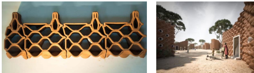
Figura 160: Parede de argila impressa em 3D. Fonte: IAAC 83 (2021) adaptado pela autora (2021).
