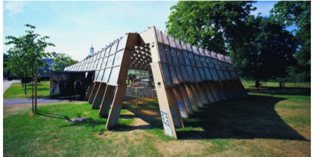
Figura 61: Pavilhão Serpentine - vista externa. Fonte: Afaconsult (2019) adaptado pela autora (2021).
