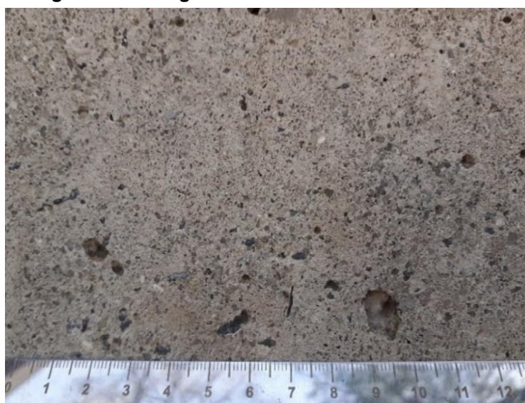
Figura 112 - Imagem ilustrando orifícios de até 1cm.
