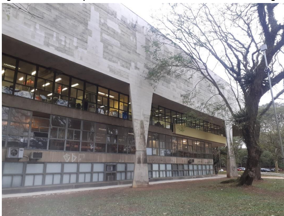
Figura 110 - Pilar em que foram realizados os ensaios ao centro da imagem.
