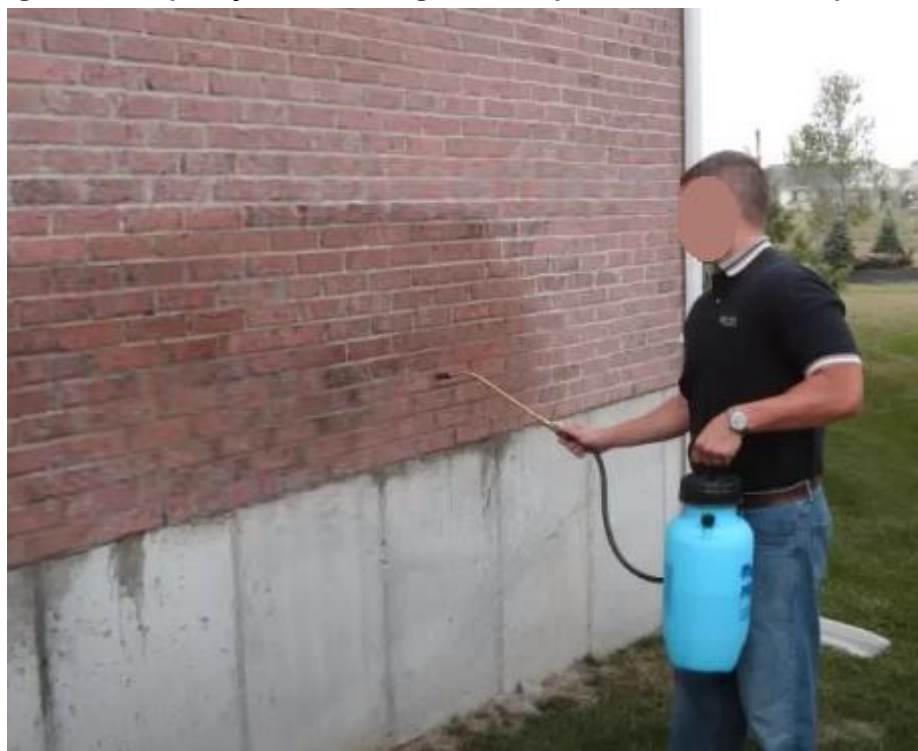
Figura 101 - Aplicação de hidrofugante com pulverizador de baixa pressão.
