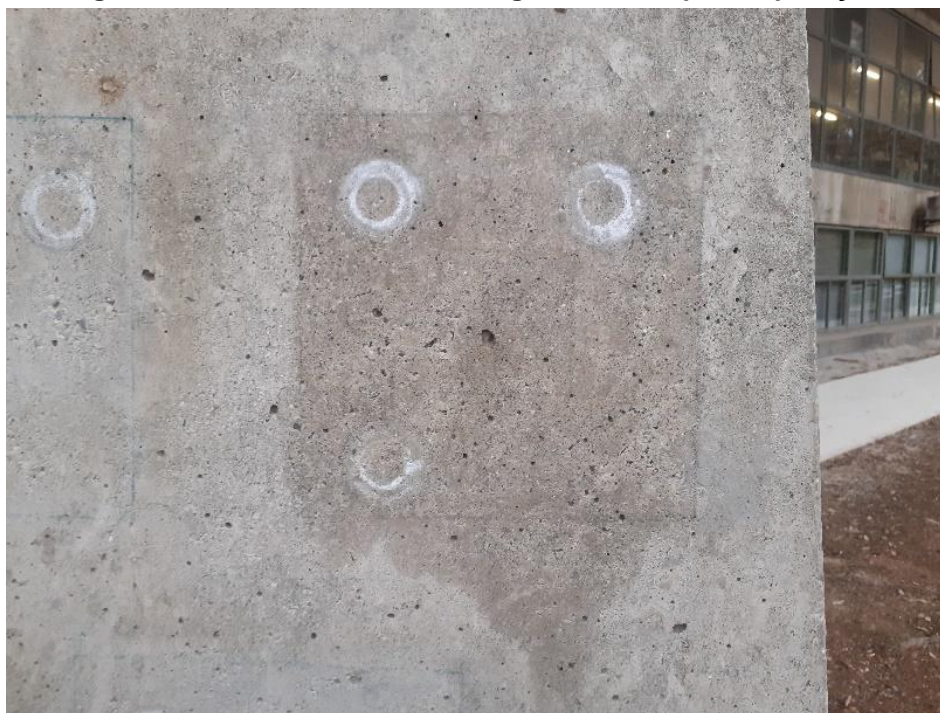
Figura 126 - Área do creme hidrofugante horas após a aplicação.
