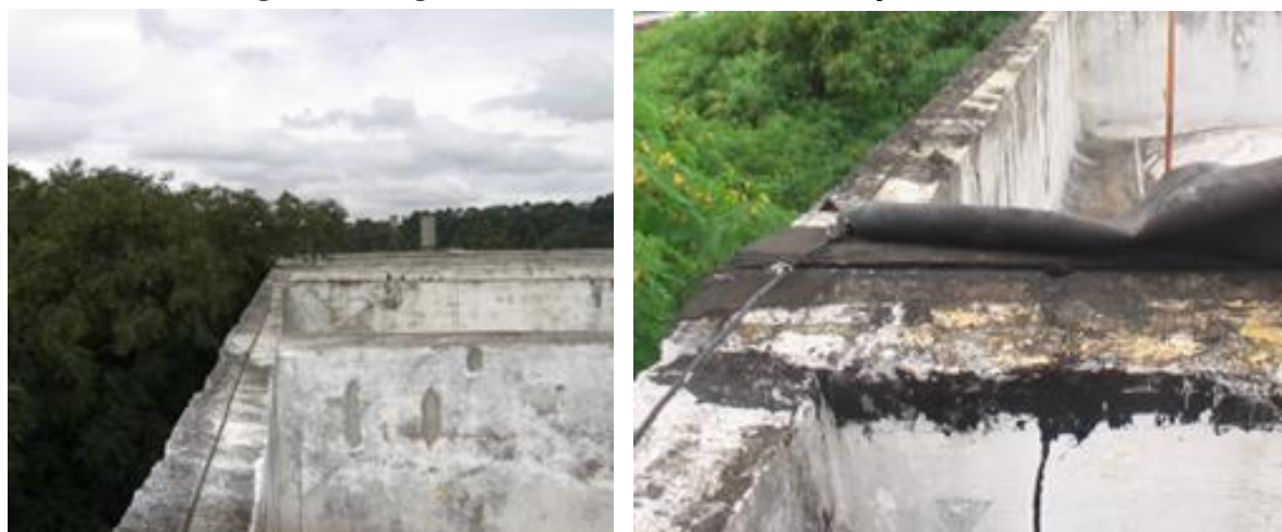
Figura 31 - Vigas de cobertura antes da instalação dos rufos.
