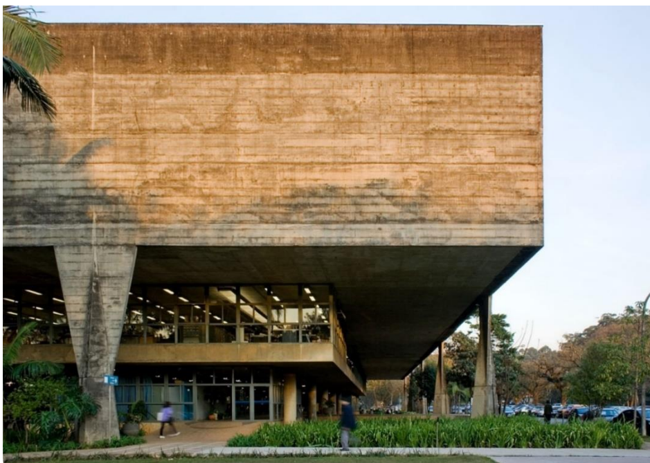
Figura 9 - Faculdade de Arquitetura e Urbanismo da USP, Vilanova Artigas e Carlos Cascaldi, 1969.
