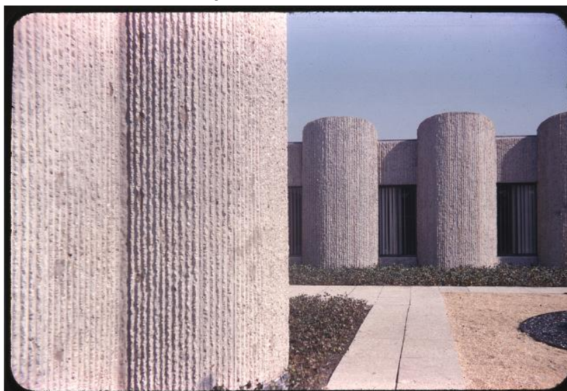
Figura 16 - Endo Pharmaceutical Building, Paul Rudolph. 1964 O arquiteto procurou deixar a superfície texturizada.
