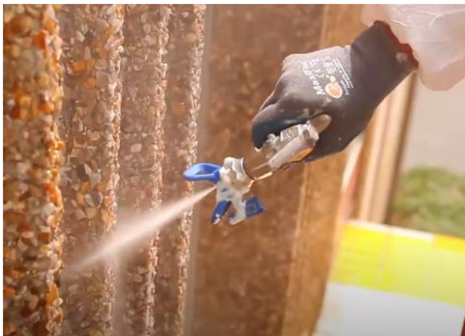
Figura 99 - Aplicação do hidrofugante com spray airless .
