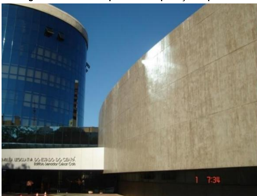
Figura 41 - Concreto aparente com proteção superficial.
