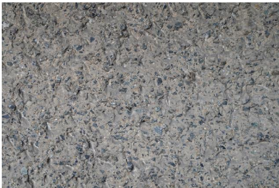
Figura 22 - Superfície modificada com martelo texturizador ( bush hammer ), Barbican Center, Chamberlin, Powell & Bon, Londres, Reino Unido, 1976.
