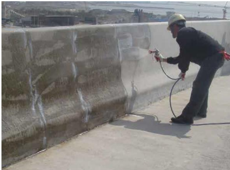
Figura 100 - Aplicação de hidrofugante com spray airless .
