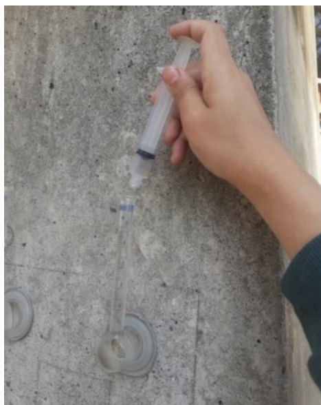
Figura 148 - Utilização de seringa para preenchimento dos tubos de Karsten.
