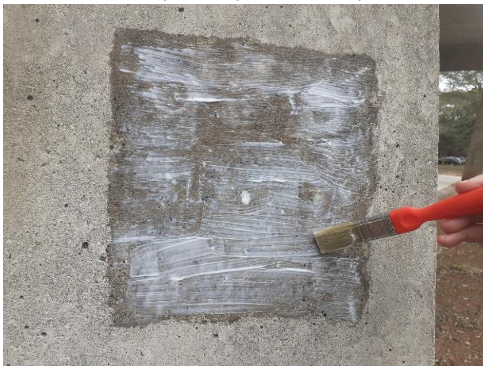
Figura 124 - Pincel utilizado para a aplicação do creme hidrofugante. Ao centro da imagem, o orifício da superfície foi preenchido com o produto.
