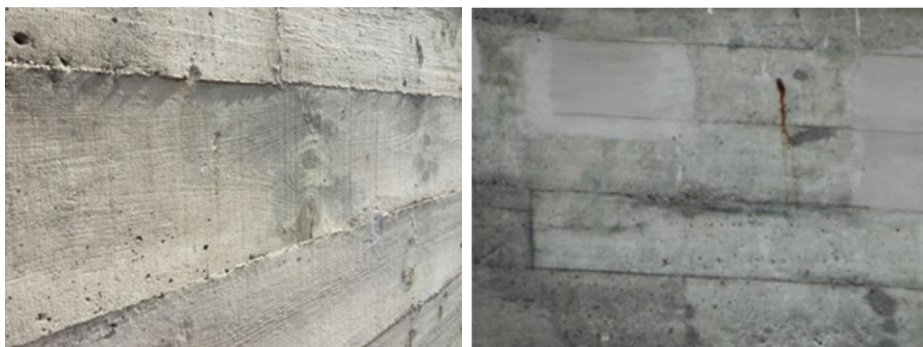
Figura 33 – Comparação entre superfície de concreto original e sem reparo (esquerda) e superfície com reparo (direita).
