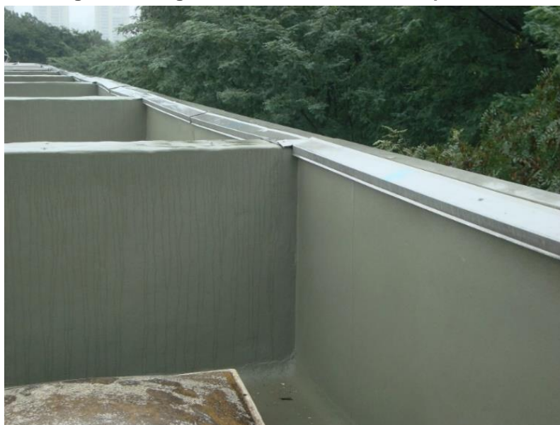
Figura 32 - Vigas de cobertura com rufo e poliureia.
