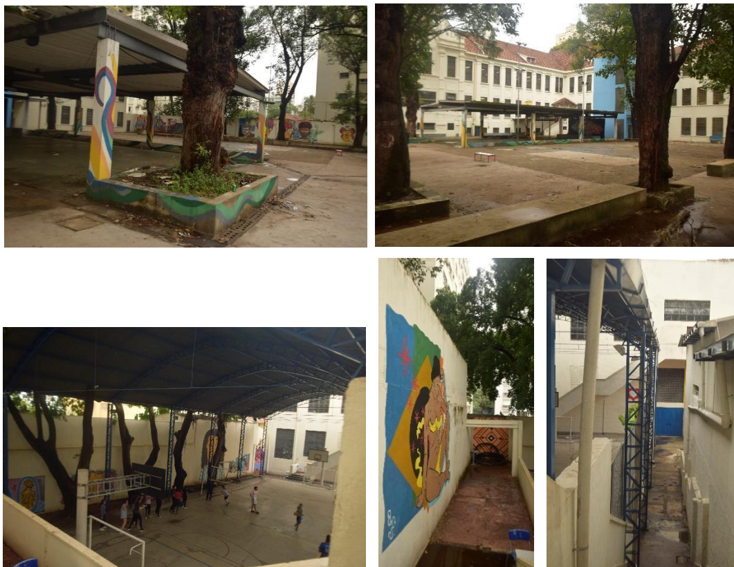
Figura 44: ECS A – Walkthrough - quadras e galpão - ambientes de vivência externos
