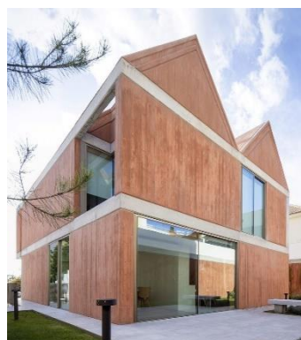
Figura A.56: Casa em São Pedro do Estoril.
