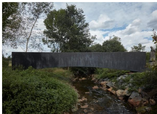
Figura A.58: Ponte de Concreto Negro.
