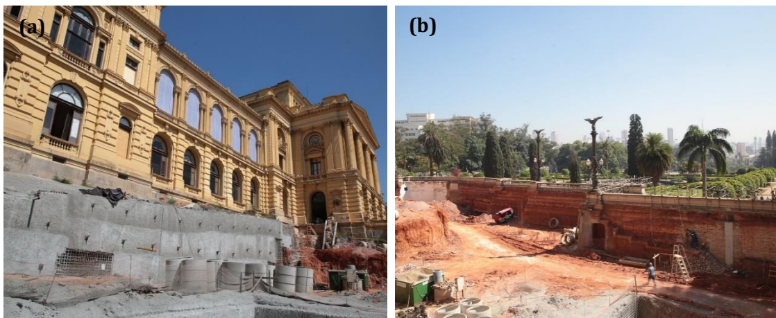
Figura 30: Museu Paulista - (a) e (b) Em construção o novo espaço de acolhimento.
