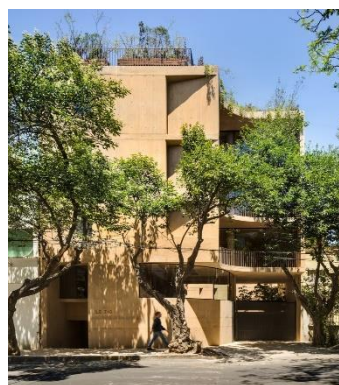
Figura A.49: Edifício LC710.
