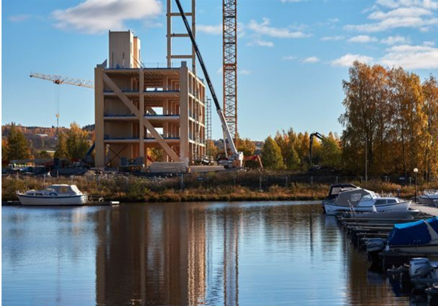
Figura 12: Edifício Mjøstårnet durante a montagem da estrutura.
