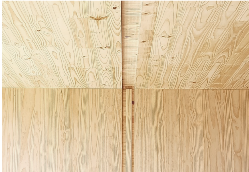
Figura 49: Rasgos para eletrodutos e demais instalações, posicionados de forma alinhada à lamela externa dos painéis de MLCC (parede e laje).
