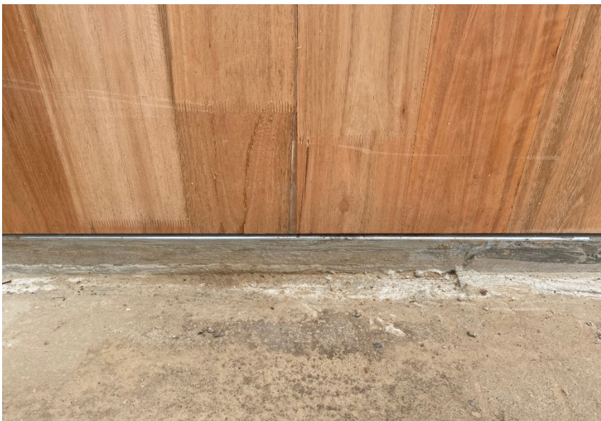
Figura 54: Conexão de um painel de MLCC na fundação de concreto por meio de um perfil metálico.
