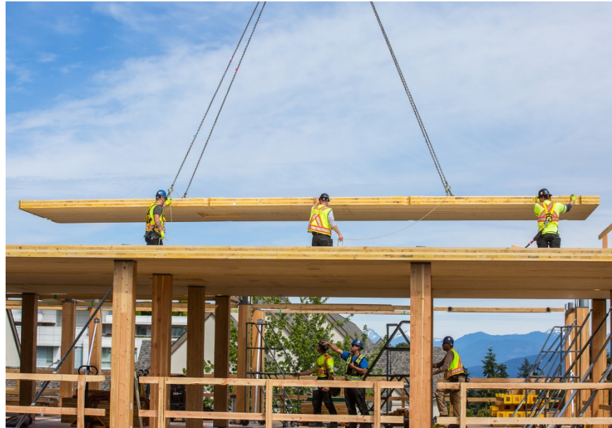
Figura 14: Edifício Brock Commons durante a montagem da estrutura.
