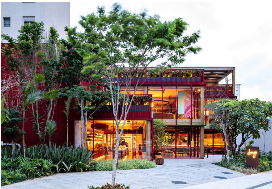
Figura 26: Loja conceito de fábrica de chocolates construída com painéis de MLCC e estrutura de MLC.
