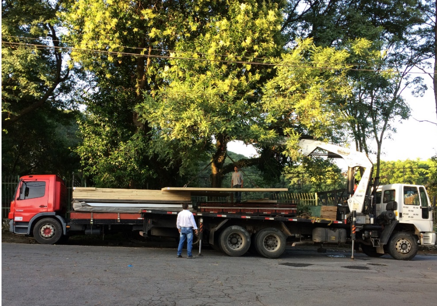
Figura 51: Transferência da carga para o caminhão munck para montagem da edificação.
