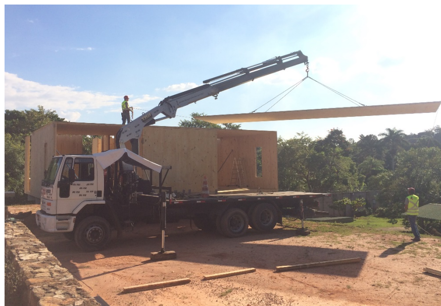
Figura 35: Posicionamento de um painel de MLCC com o auxílio de um caminhão munck .
