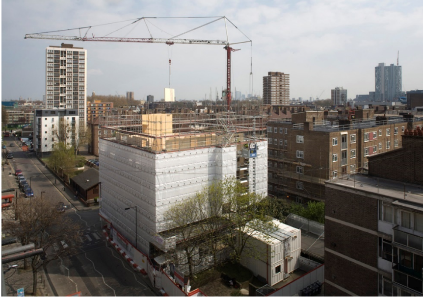
Figura 10: Edifício Stadthaus durante a montagem da estrutura.
