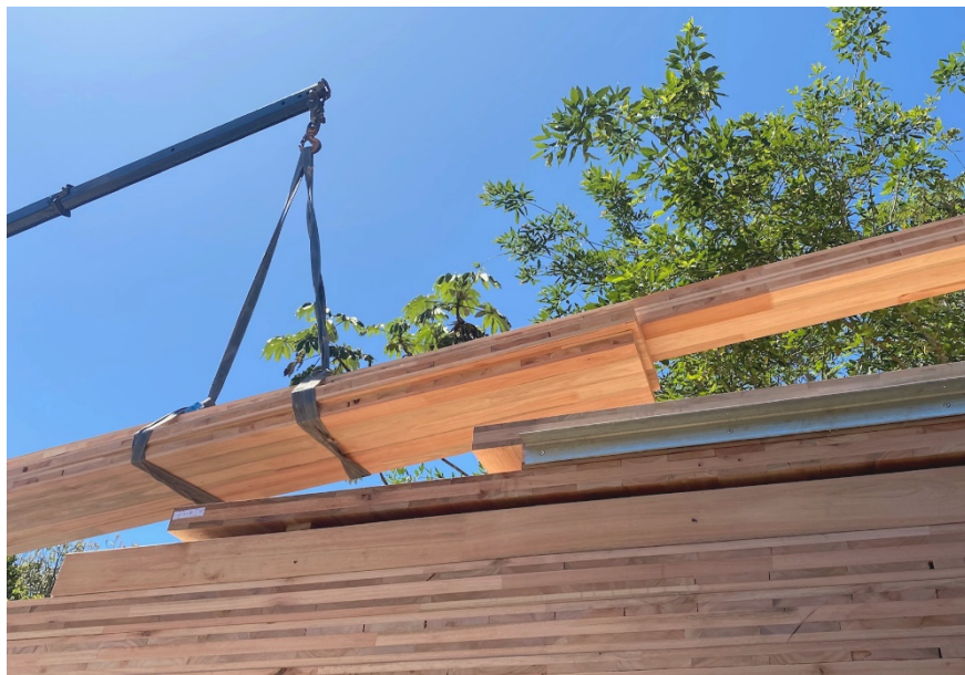
Figura 65: Içamento de pacote com vigas de MLC para transporte e montagem.
