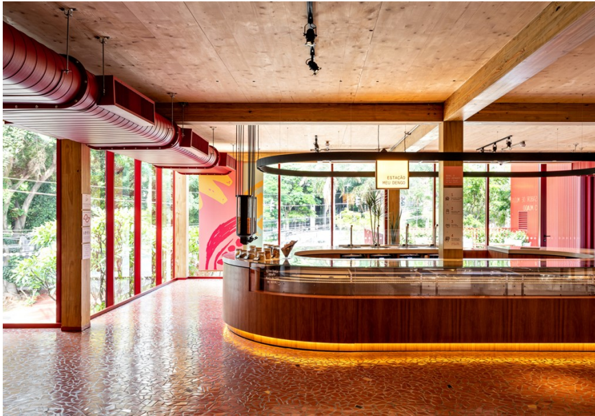
Figura 25: Loja conceito de fábrica de chocolates construída com painéis de MLCC e estrutura de MLC.
