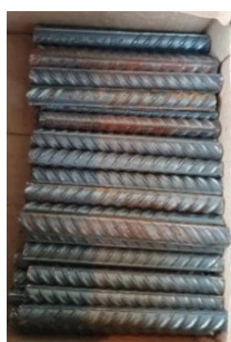
(a) barra oxidadas
