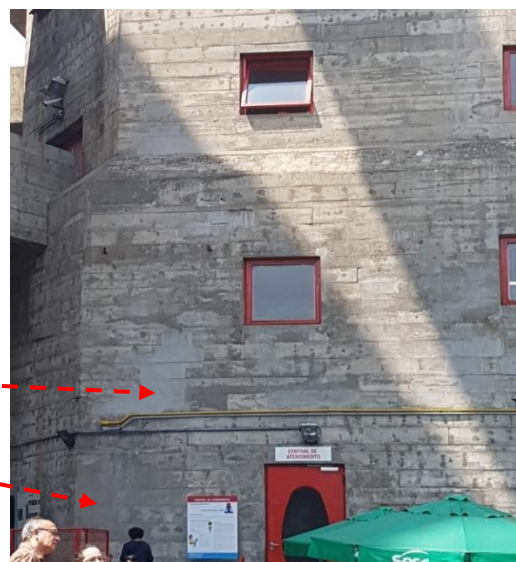
Figura 7: Edifício de circulação e serviços do Sesc Pompéia: (a) vista geral do edifício, (b) detalhe de reparos pontuais executados em diferentes intervenções executados com argamassa industrializada.
