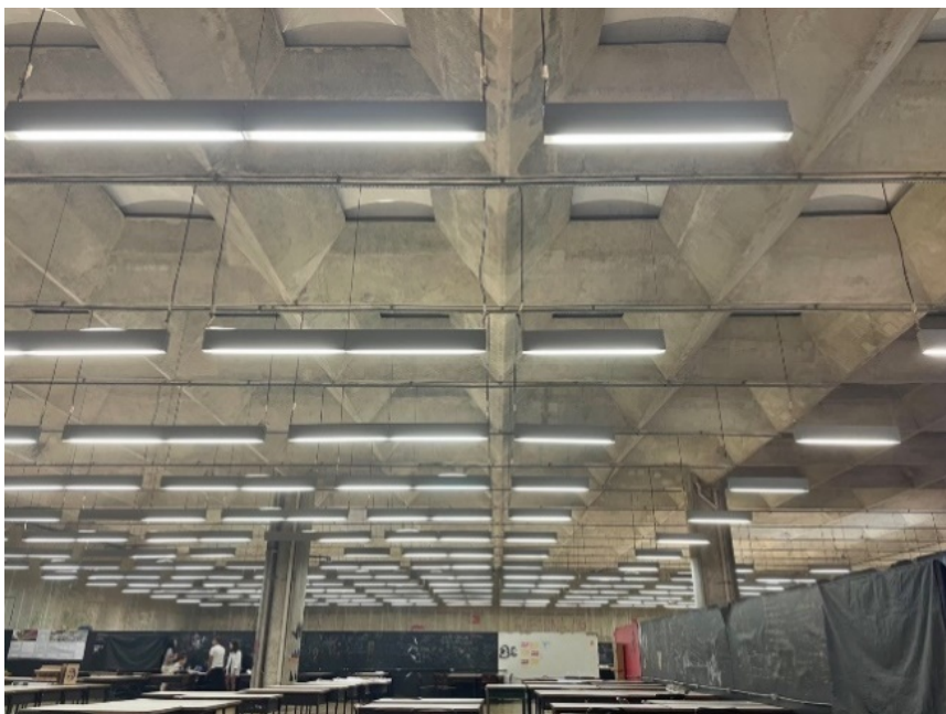
Figura 75 - FAU-USP: Iluminação elétrica
