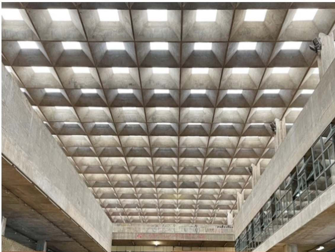
Figura 25 - FAU-USP: Cobertura de domos
