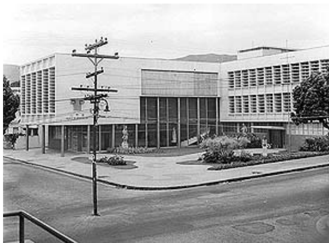
Figura 4 - Escola de Arquitetura da UFMG
