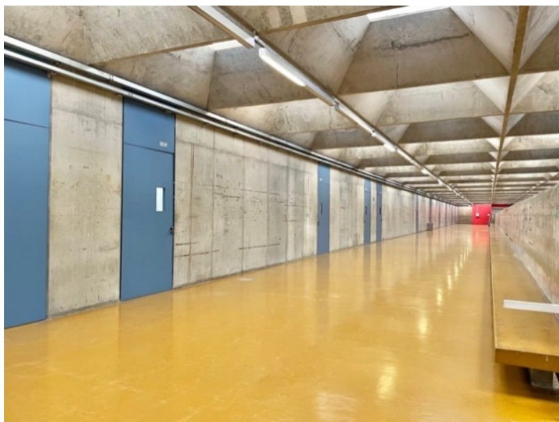
Figura 42 - FAU-USP: Circulação entre salas de aula
