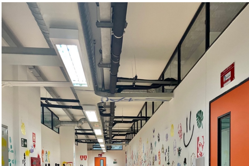
Figura 87 - FAU-Mackenzie: Janelas internas
