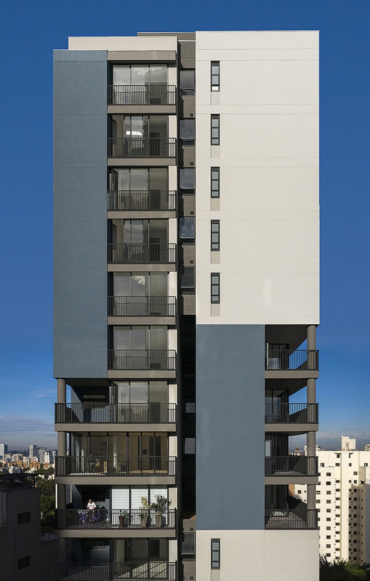
Figura 40. Edifício SPOT393. Foto: idezarvos.com
