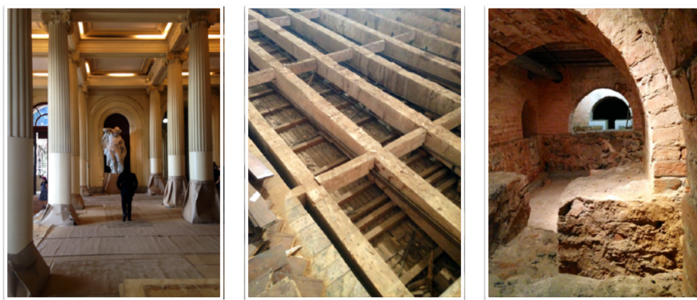
Figura 87. Saguão com piso, colunas e estátua protegidos; piso do pavimento superior desmontado para verificação da estrutura de madeira; estrutura em abóboda de tijolos no subsolo
