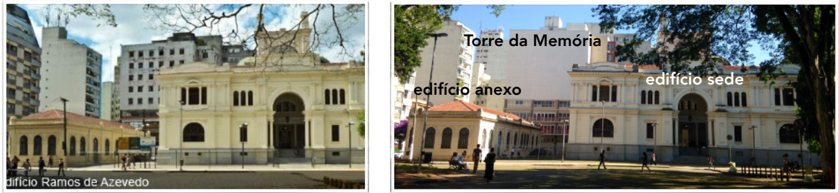
Figura 80. Conjunto de edifícios do AHM, antes e depois das obras de reforma
