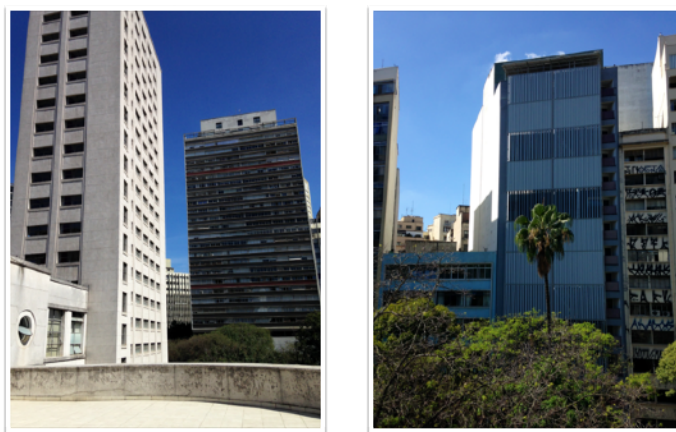
Figura 84. Imagem à esquerda, torre com as áreas de guarda do edifício sede vista a partir da cobertura do embasamento. Imagem à direita, edifício anexo (hemeroteca), vista a partir do edifício sede
