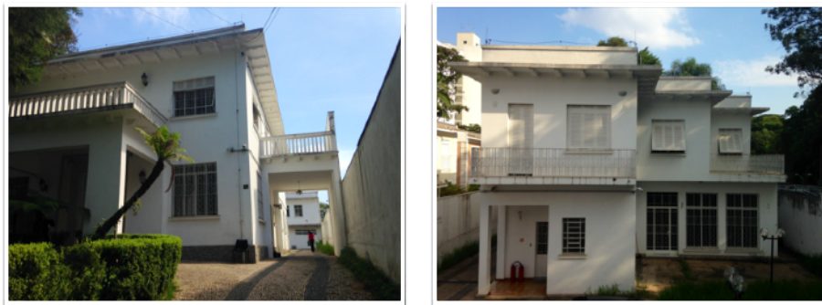
Figura 88. Edifício temporário para reserva técnica do acervo em papel (frente e fundos)
