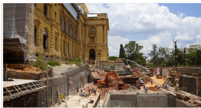
Figura 91. Obras de escavação e contenção para ampliação no subsolo
