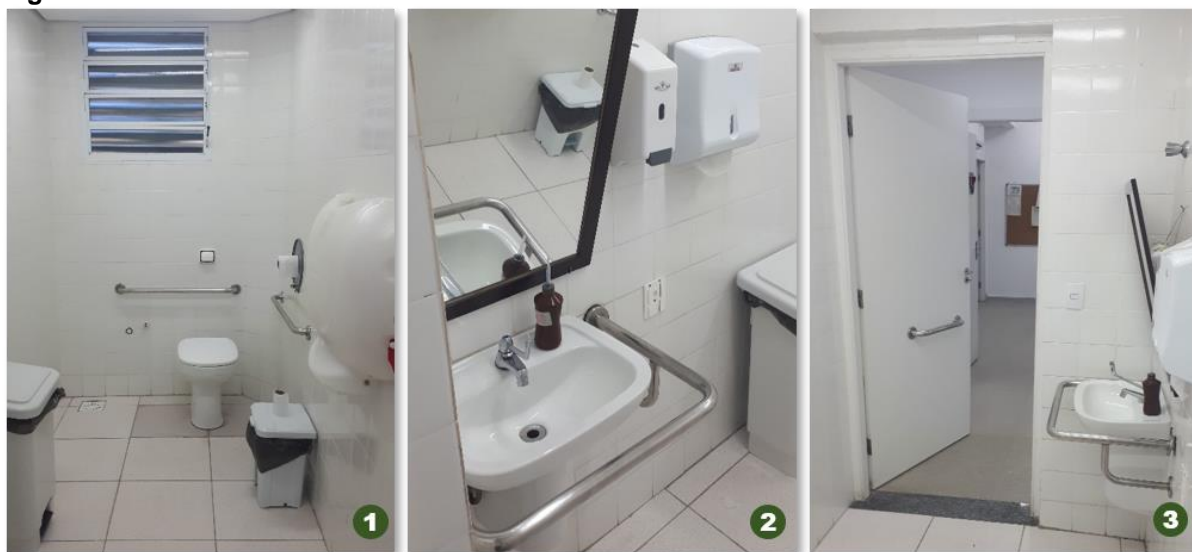
Figura 34. Sanitário Acessível na UBS Bom Retiro.
