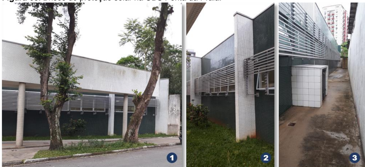
Figura 68. Brises de proteção solar na UBS Ponta da Praia.
