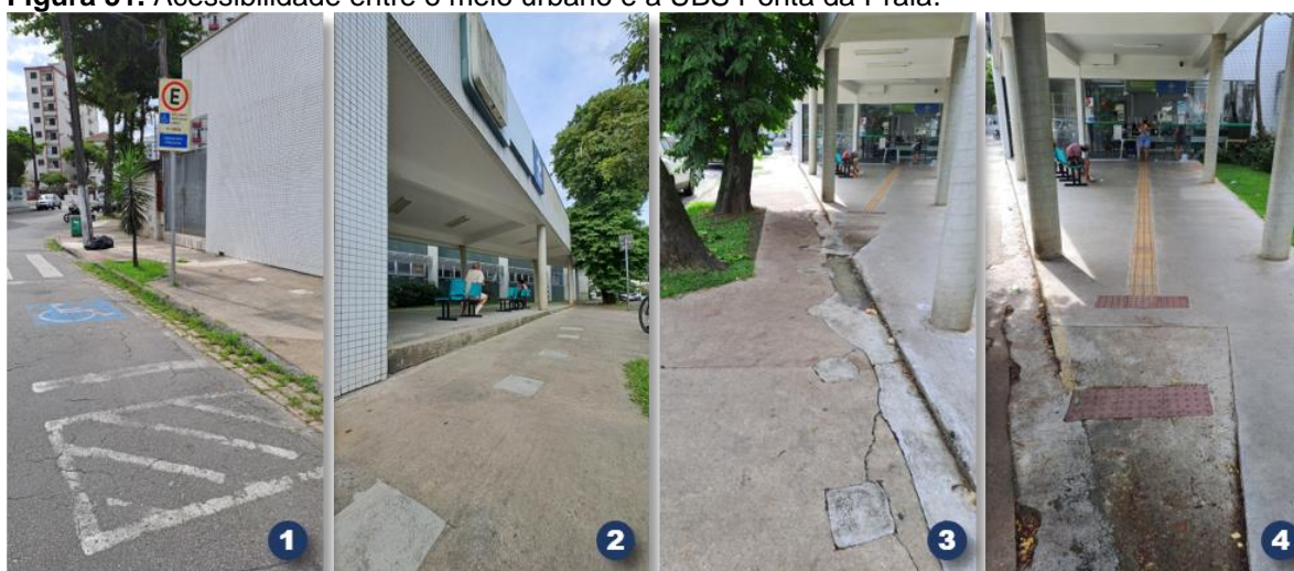
Figura 51. Acessibilidade entre o meio urbano e a UBS Ponta da Praia.
