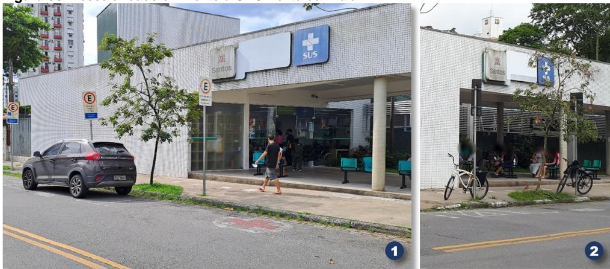
Figura 50. Acessibilidade em frente à UBS Ponta da Praia.
