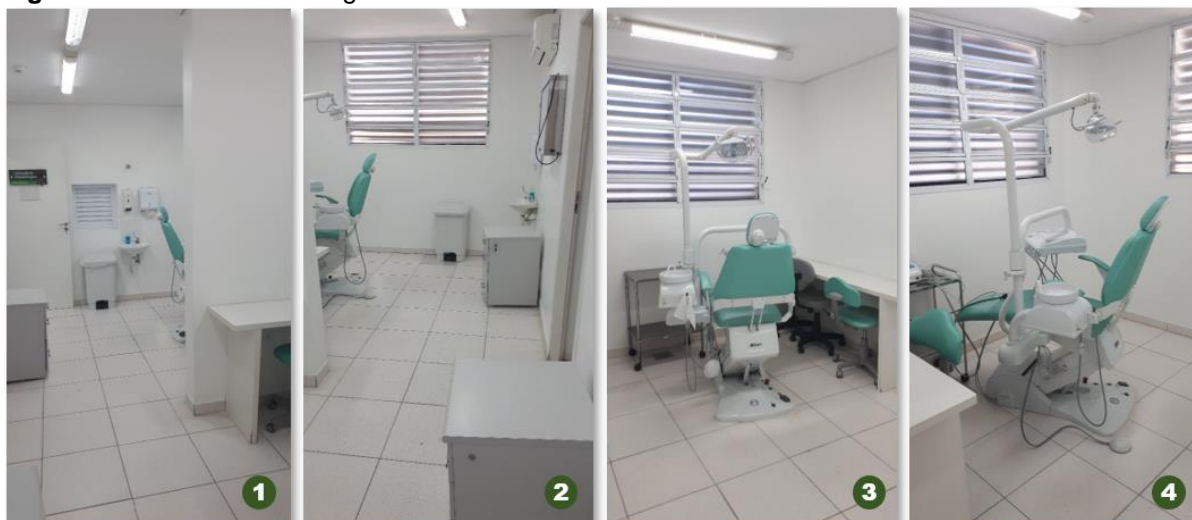
Figura 47. Sala da Odontologia na UBS Bom Retiro.
