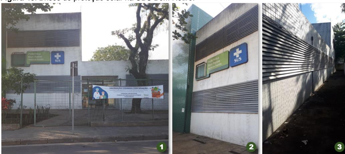
Figura 43. Brises de proteção solar na UBS Bom Retiro.
