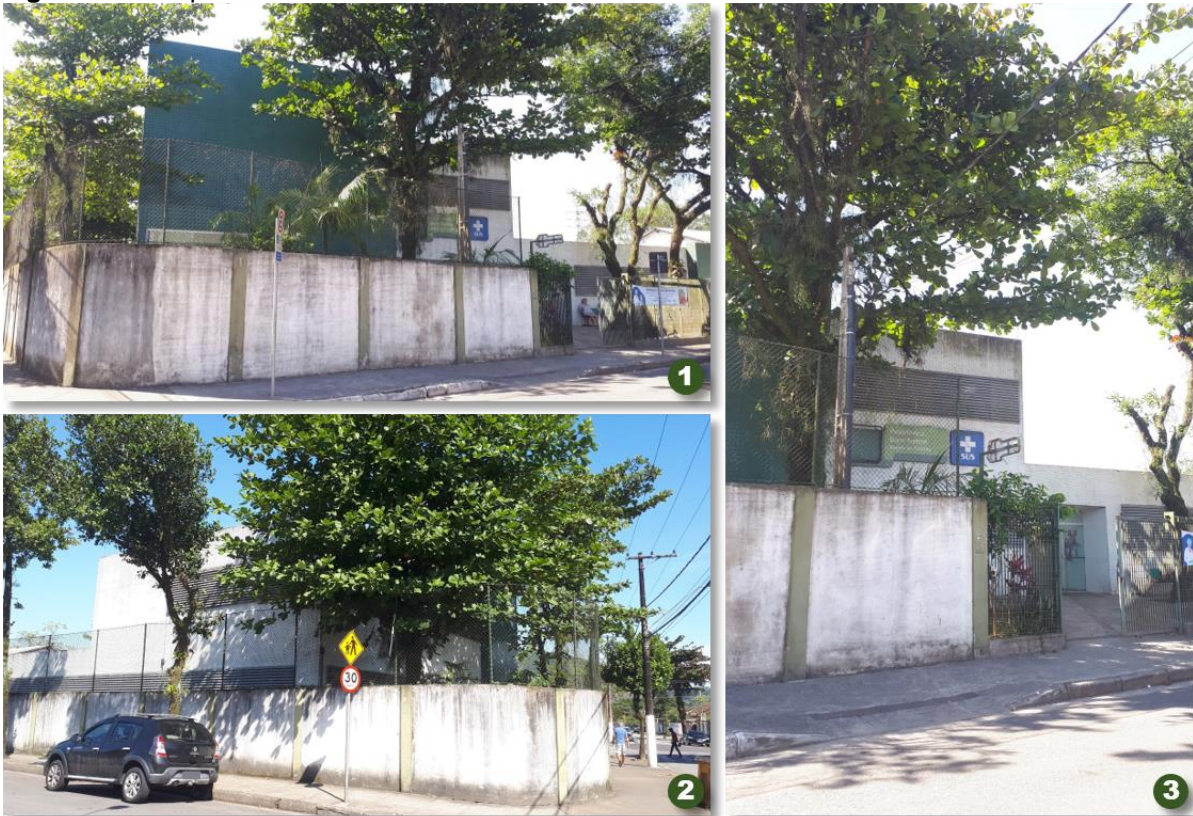
1) Fachada da UBS vista da esquina; 2) Vista lateral da UBS a partir da Rua Amadeu Barbielini; 3) Vista do acesso dos usuários à UBS. Fonte: Acervo do autor, 2021.
