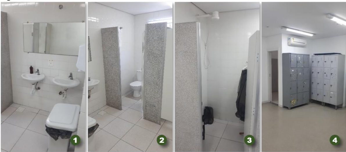
Figura 35. Sanitário Masculino e Feminino de funcionários da UBS Bom Retiro.
