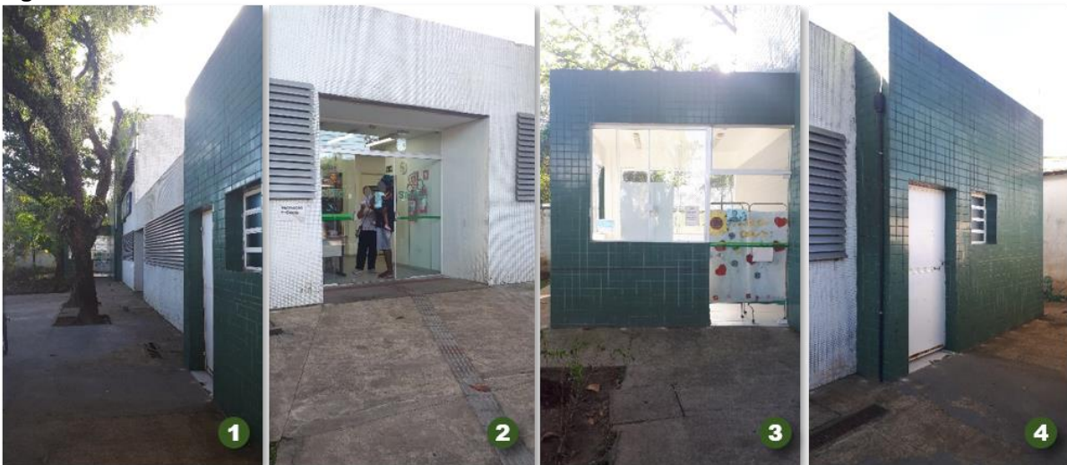
Figura 28. Acesso ao interior da UBS Bom Retiro.
