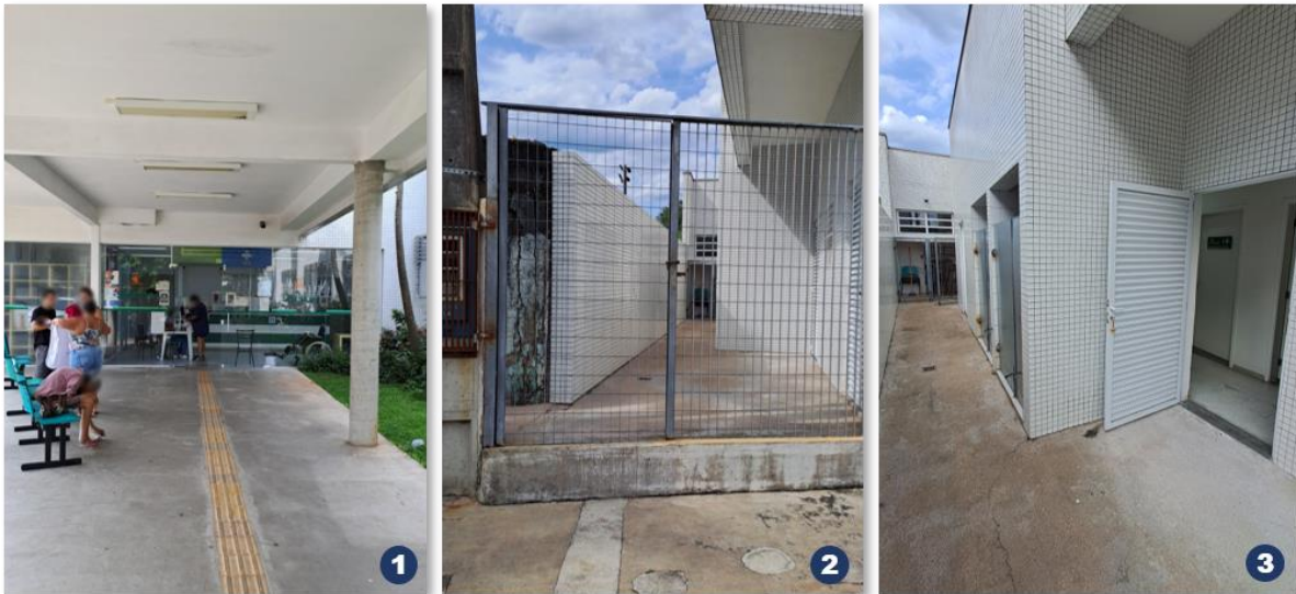
Figura 52. Acesso ao interior da UBS Ponta da Praia.
