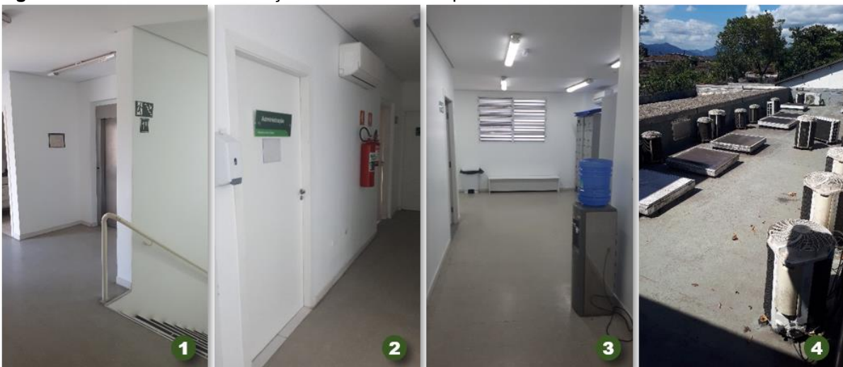
Figura 31. Corredores de circulação no Pavimento Superior da UBS Bom Retiro.
