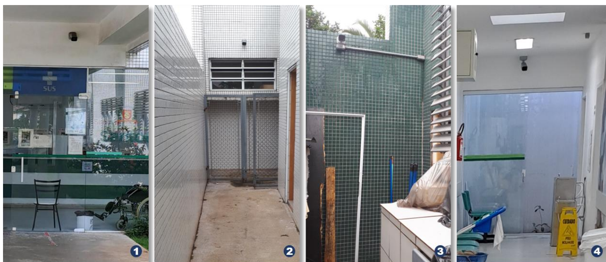
Figura 80. Câmeras de monitoramento na UBS Ponta da Praia.
