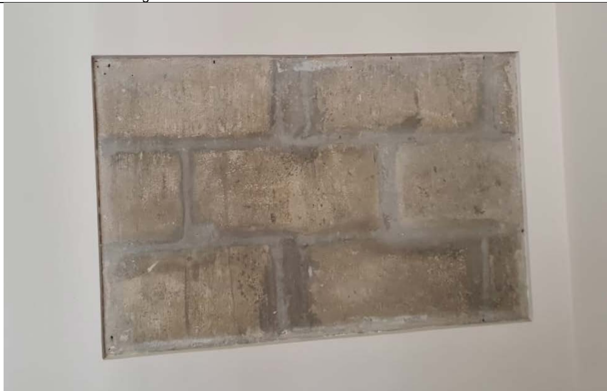
Figura B.13 – Paredes do Solar Blocos de Sílico Calcário.
