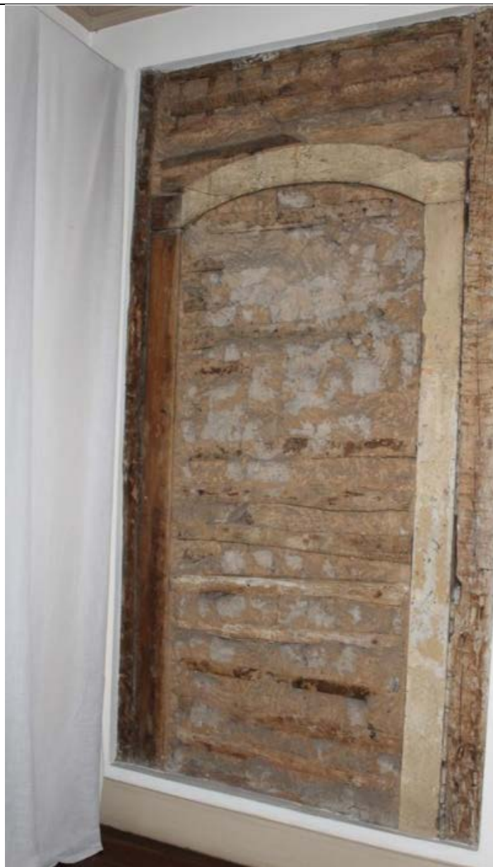
Figura B.6 - Fotografia da Vitrine expositiva - parede em Pau a Pique, Solar da Marquesa.
