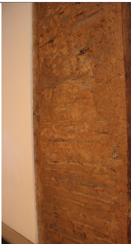
Figura B.2 – Fotografia da vitrine expositiva - parede em Taipa de Pilão, Solar da Marquesa.
