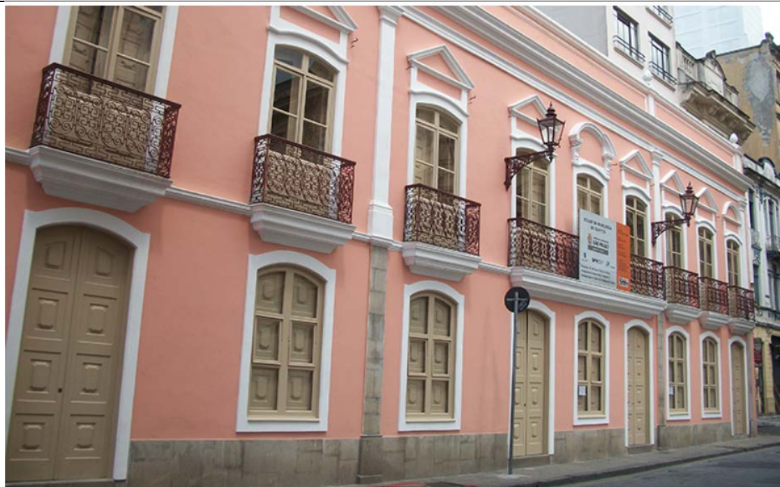
Figura 4.15 - Fachada atual do Solar da Marquesa.
