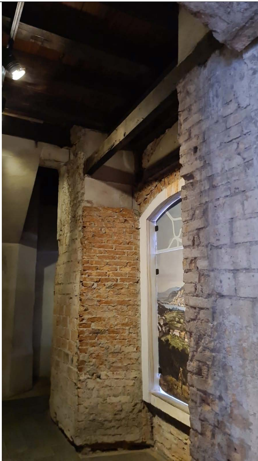
Figura B.10 - Fotografia da vitrine expositiva - Parede em Tijolo Maciço, Solar da Marquesa.
