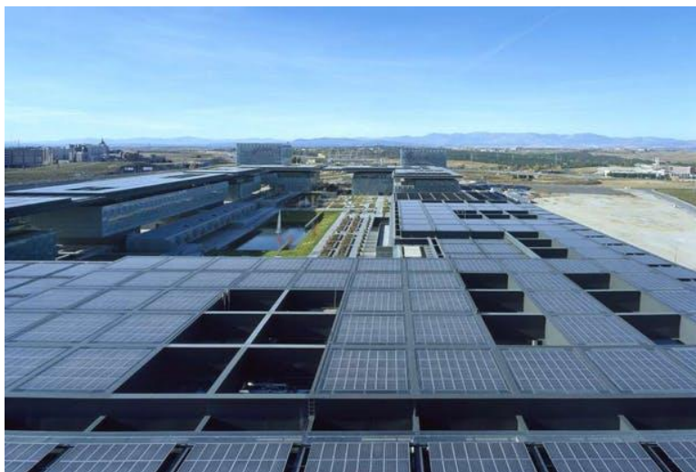
Figura 28 - Cobertura da sede da Telefónica em Madri
