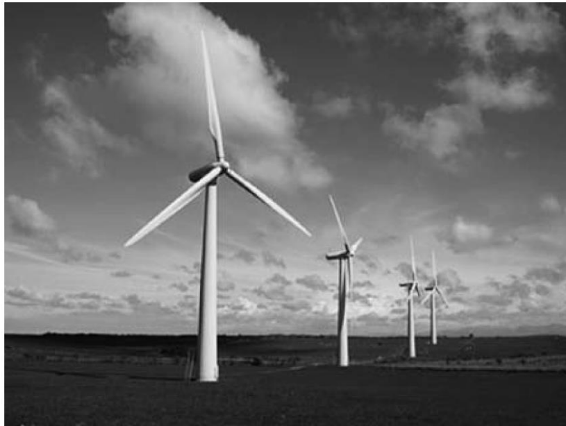
Figura 39 - Exemplo de turbina de eixo horizontal.
