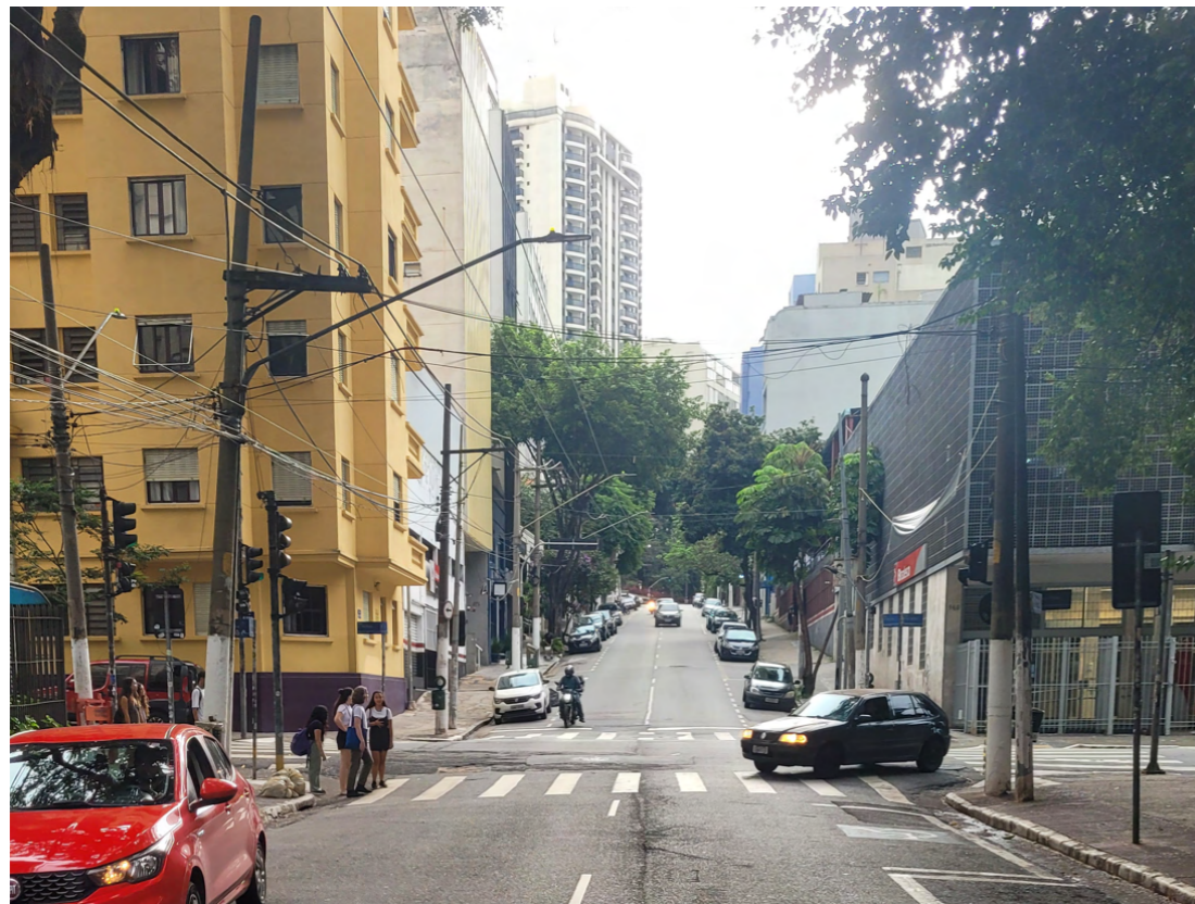
9.6. Esquina entre as ruas Major Sertório (trecho 11) e Dr. Vila Nova (trecho 12), na qual há postes utilizados para o fornecimento de energia, sinalização viária e sinalização semafórica instalados em sequência. Fonte: autoria própria.
