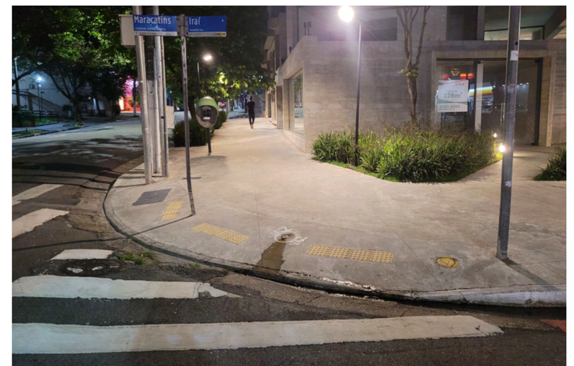
Figura 9.2. Exemplo de calçada rebaixada em toda a extensão da esquina. Fonte: autoria própria.
