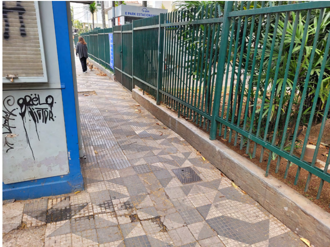
9.3. Banca de jornal inativa sobre calçada na Rua Alagoas (trecho 3). Fonte: autoria própria.
