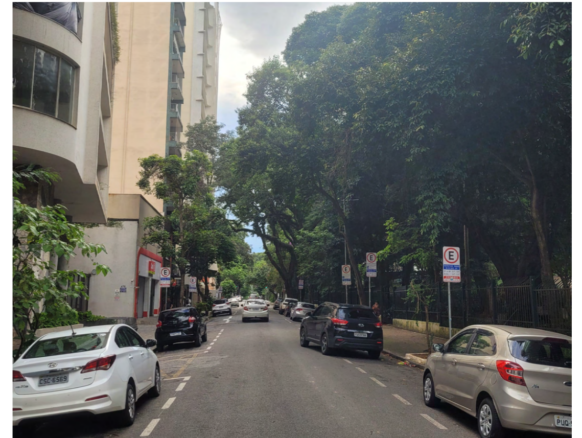
Figura 9.4. Exemplo de via com fiação subterrânea – Rua Alagoas (trecho 3). Fonte: autoria própria.
