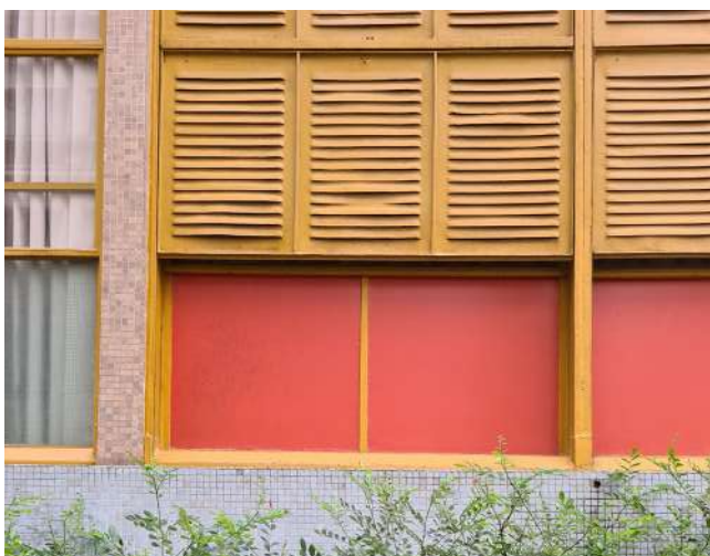
Esquadria em caixilharia metálica e painel amadeirado. Identificado na tabela como "5" e "6". Fonte: Autora, 2020.
