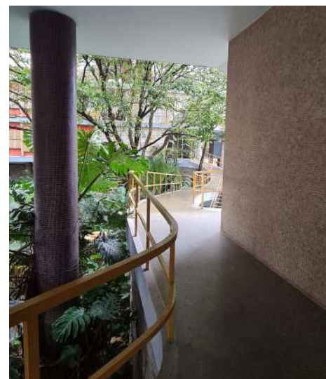
3 Parede recuada no térreo revestida com pastilhas. Identificado na tabela como "3". Fonte: Autora, 2020.
