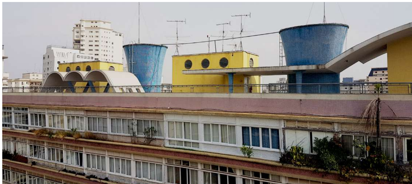
Figura 53: Terraço do bloco B. Fonte: Autora, 2020.
