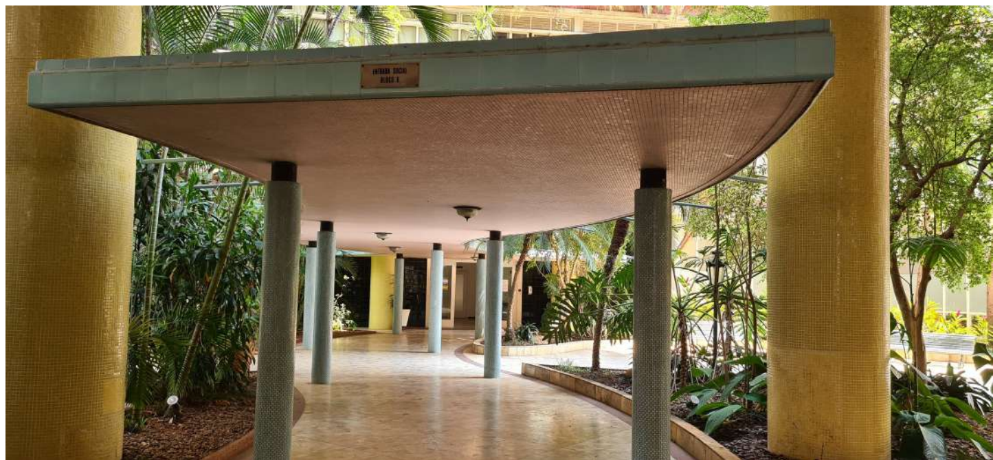
Figura 52: Marquise de ligação entre os blocos A e B. Fonte: Autora, 2020.
