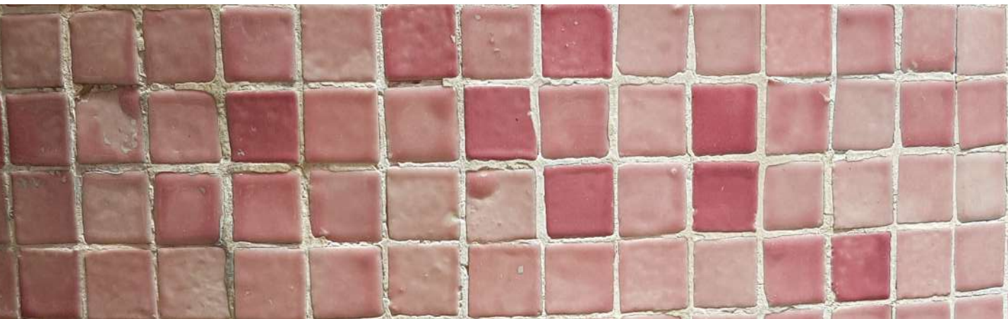
Figura 8: Pastilhas cerâmicas esmaltada revestindo o pilar do Ed. Cinderela. Fonte: Autora, 2020.
