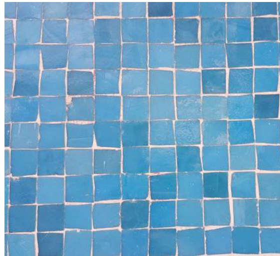
a) Marquise do terraço com pilares e coberta revestidos de pastilha. b) Volume da casa de máquinas revestido de pastilha. c) Aproximação do revestimento de pastilha no terraço. Fonte: Autora, 2020.
