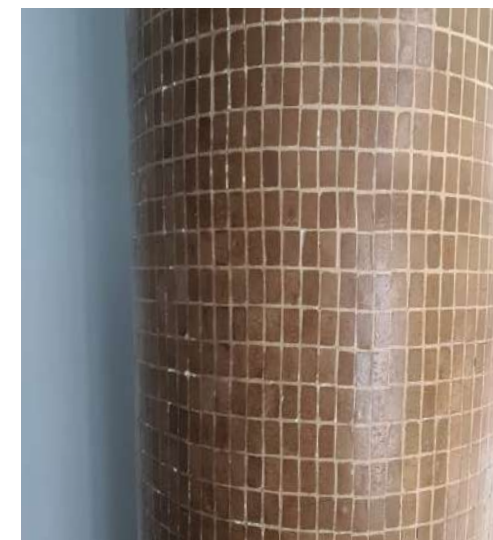
8 Pilotis interno revestido com pastilha retangular. Identificado na tabela como "8". Fonte: Autora, 2020.
