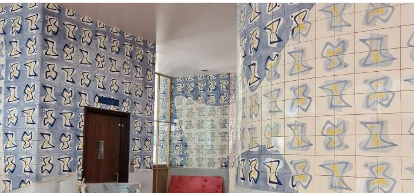
Figura 34: Hall de elevadores revestidos com painel de azulejos. Fonte: Autora, 2020.
