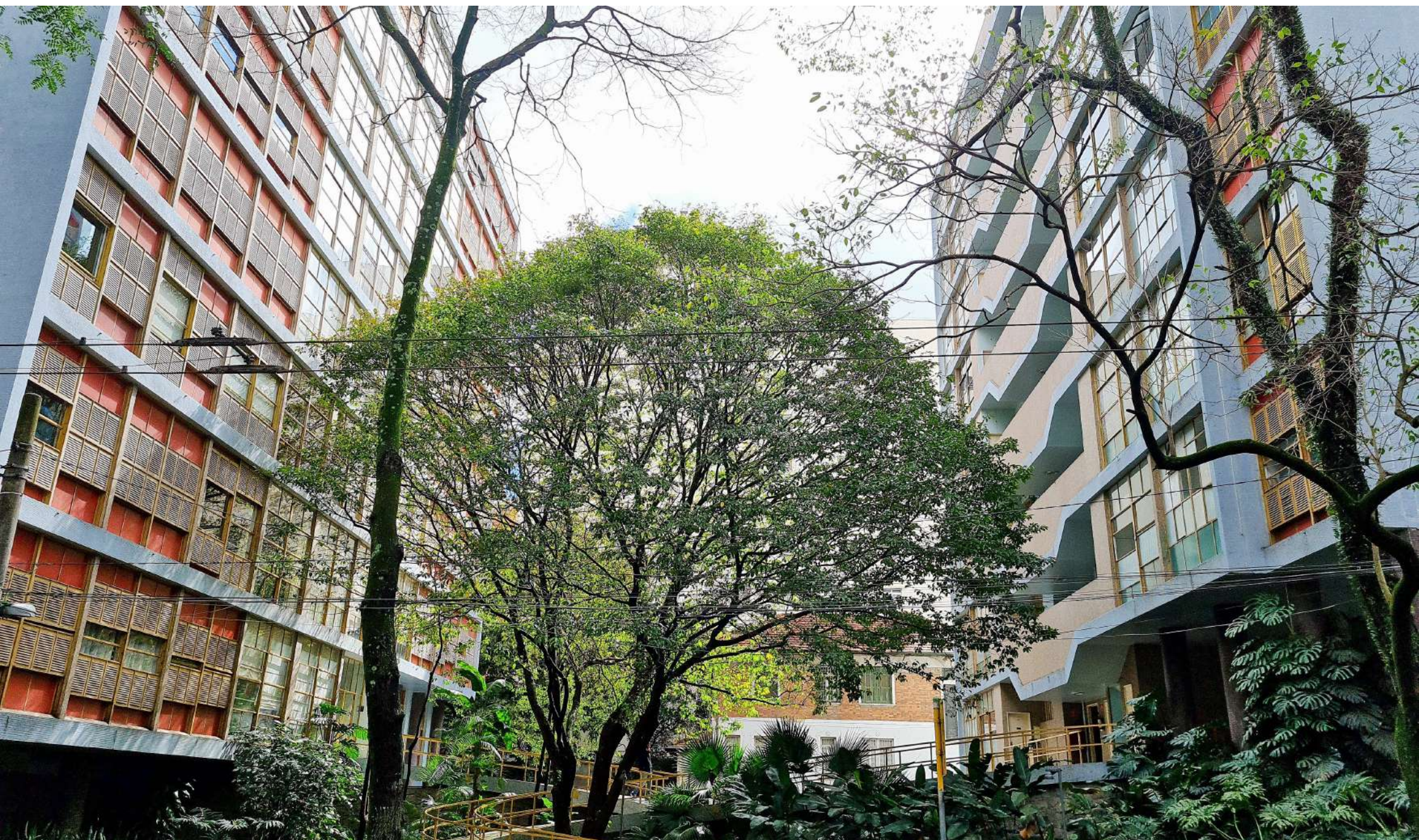
Figura 40: Jardim central do Ed. Louveira. Fonte: Autora, 2020.
